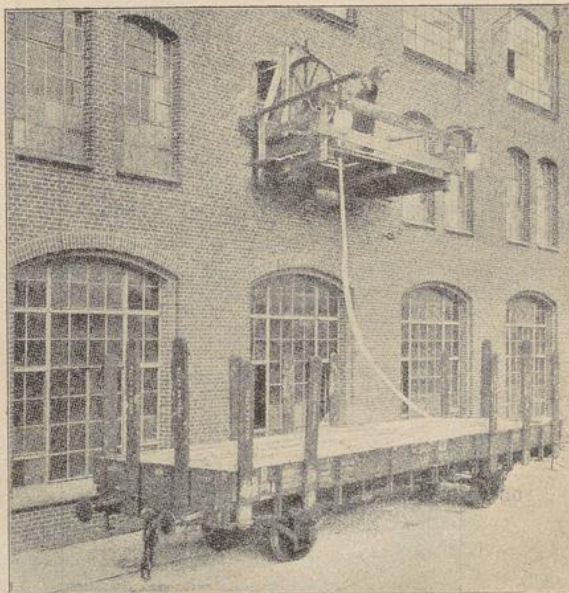
Abb. 3. Einlegen des Kabels in die Eisenbahnwagen.
