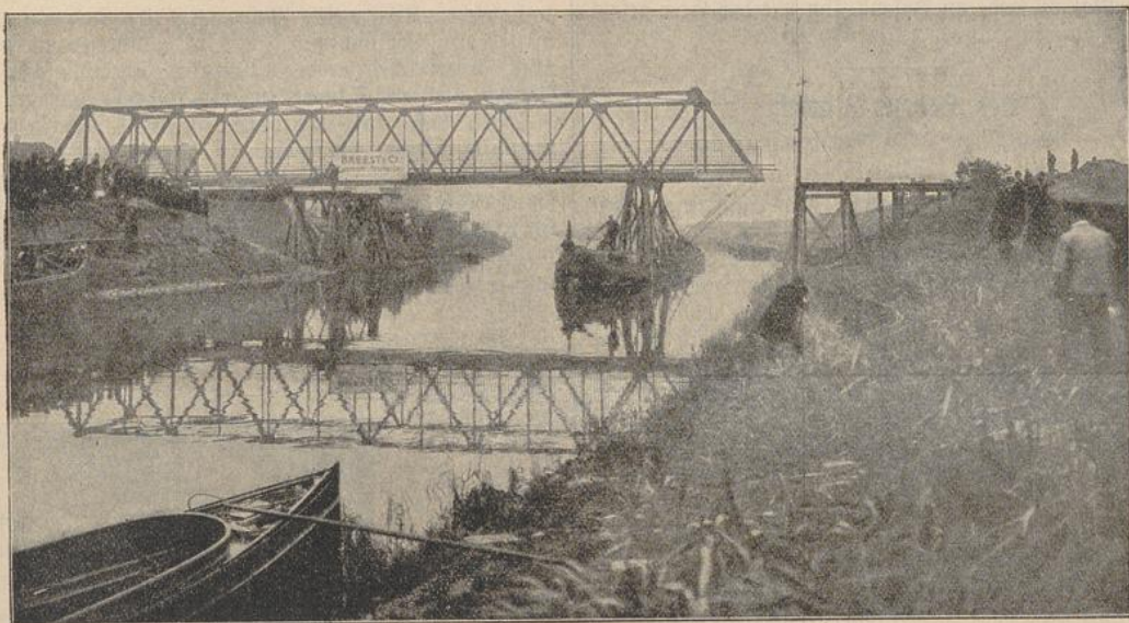
Ueberspannung der Spree in Hessewinkel bei Berlin durch eine zirka 40 Meter lange, massiv eiserne Brücke in der Zeit von 11 Minuten. Phot. Gebr. Hädel in Berlin.
