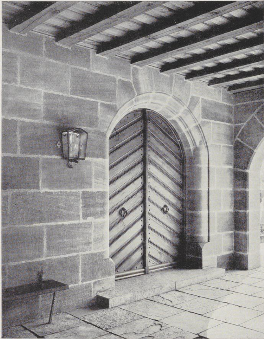
Holztüre an einem kirchlichen Gebäude
