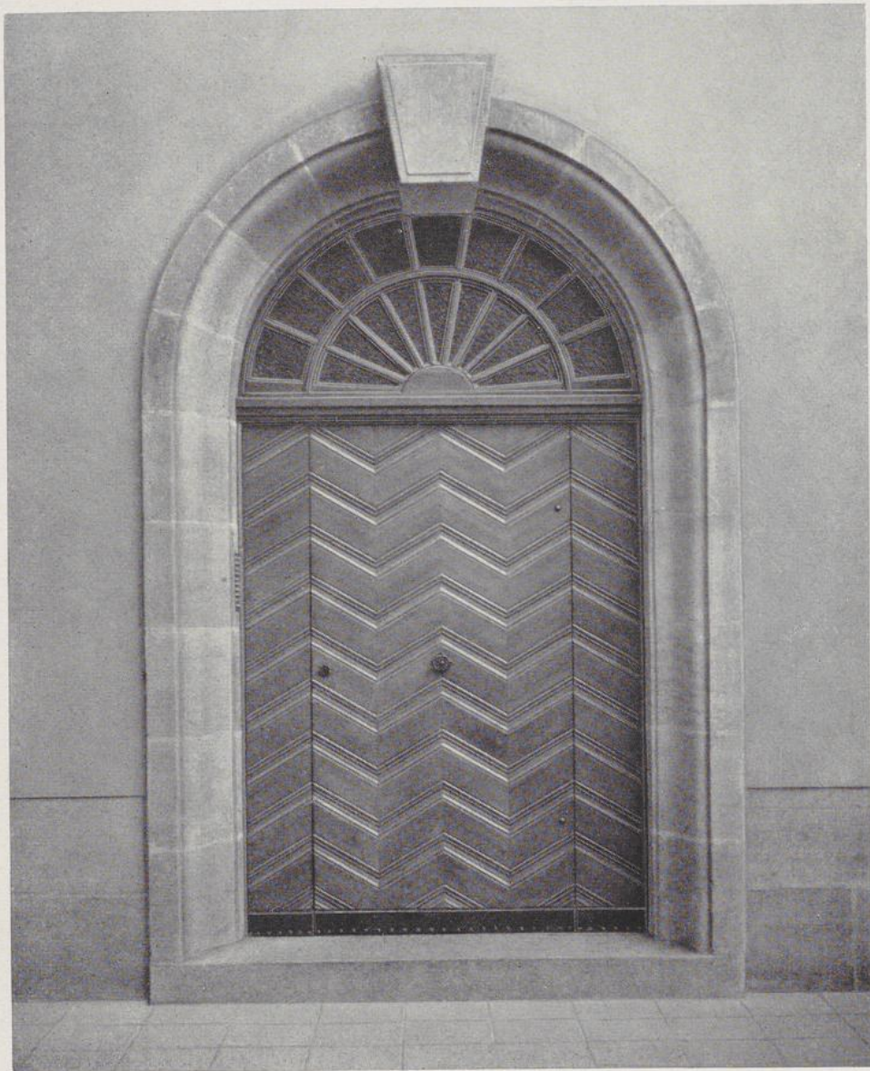
Holztüre an einem wiederaufgebauten kirchlichen Gebäude
