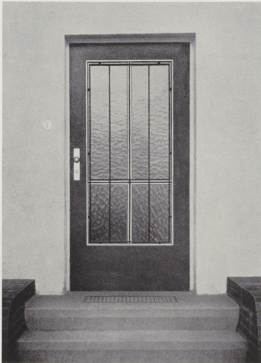
Wohnhaus-Türe, Holz, weiß abgesetzt Eisenstäbe schwarz, Glasfüllungen
