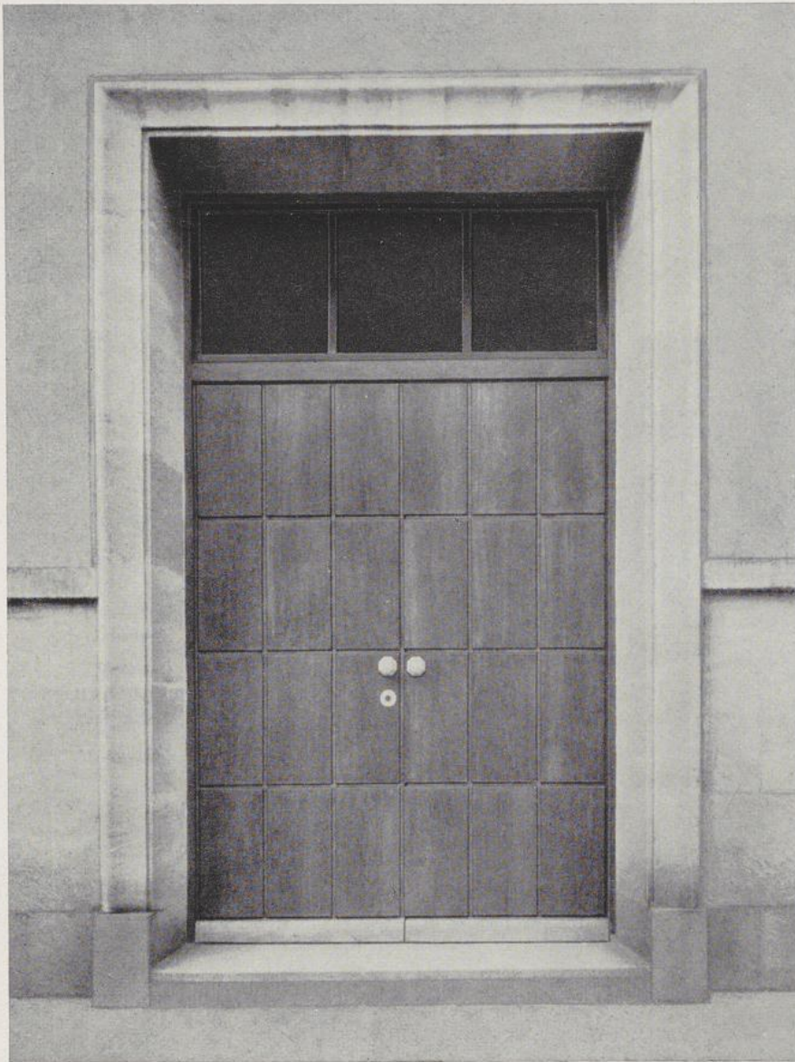
Türe an einem Geschäftshaus, Holz Oberlicht mit Glasfüllungen
