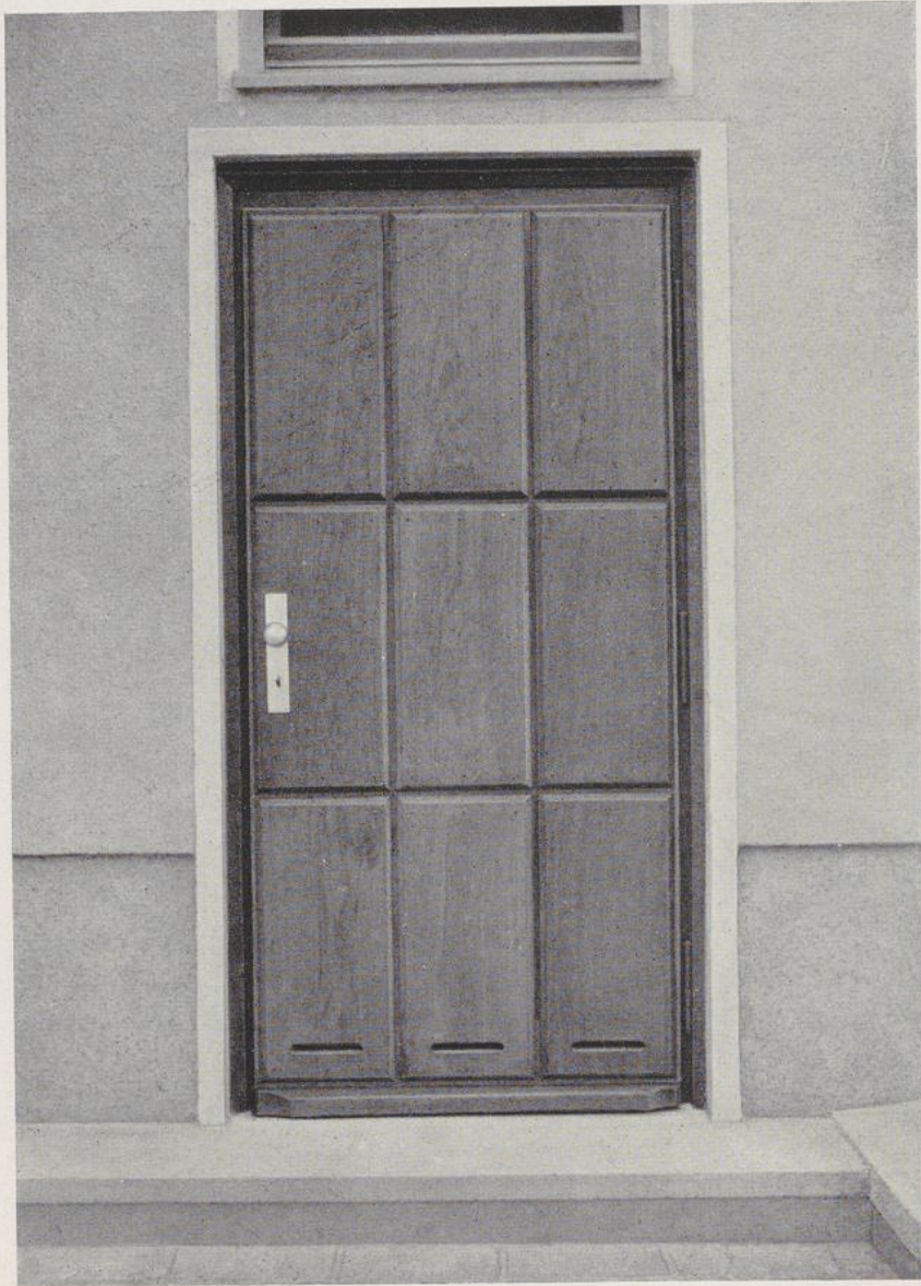
Türe zu den Nebenräumen eines Wohn-Hochhauses
