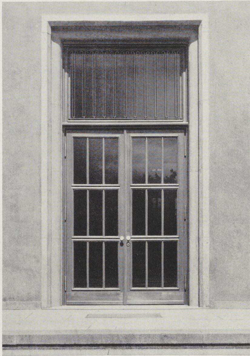
Türe an einem Schulgebäude, Holz Klarglasfüllungen, Oberlichtgitter Eisen, dahinter Glasscheibe
