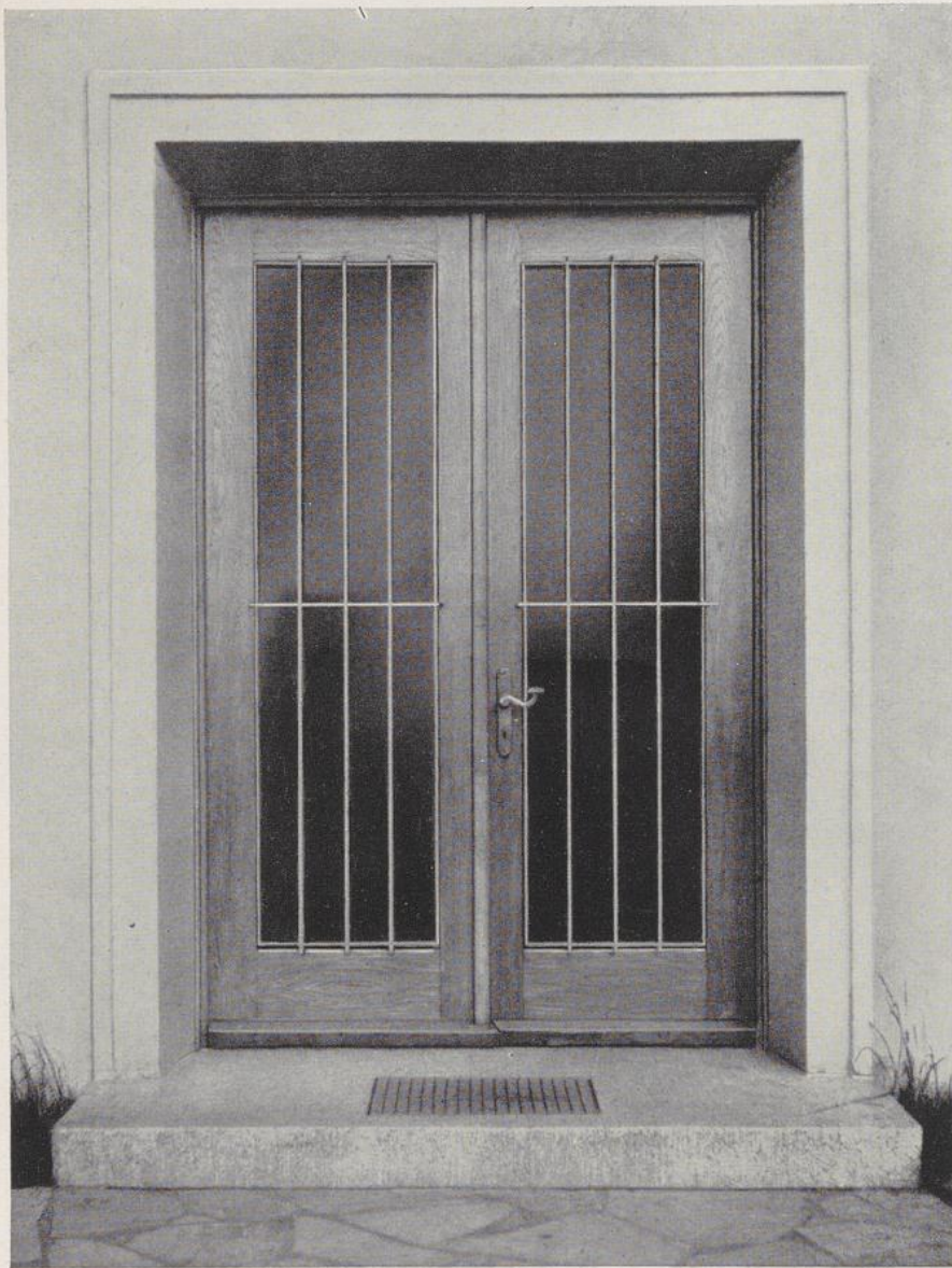
Türe an einem Industrie-Verwaltungsgebäude, Holz Eisenstäbe, Klarglasfüllungen
