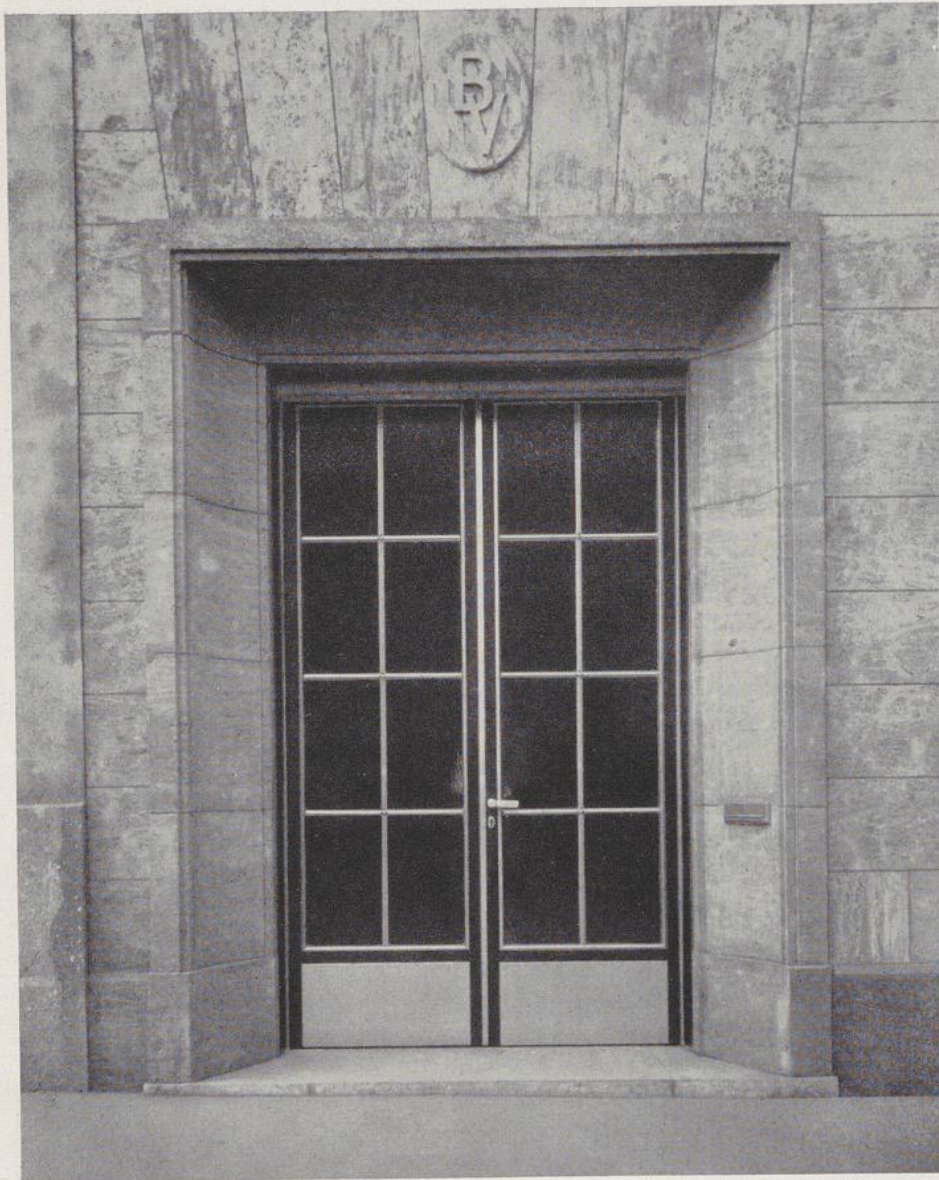
Türe an einem Bankgebäude, Metall dunkelblaugrau abgesetzt, Glasfüllungen
