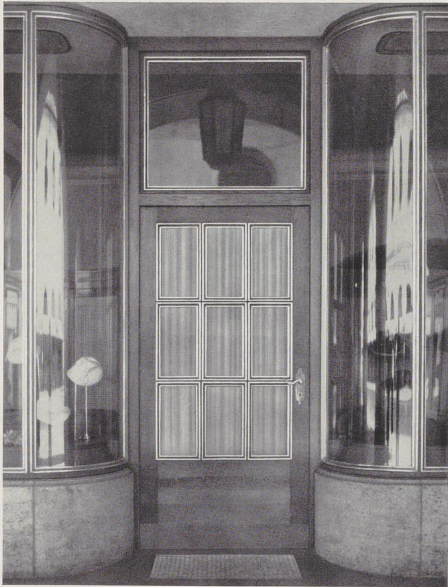
Ladentüre, Holz, Messingleisten, Klarglasfüllungen, dahinter Stoffbespannung
