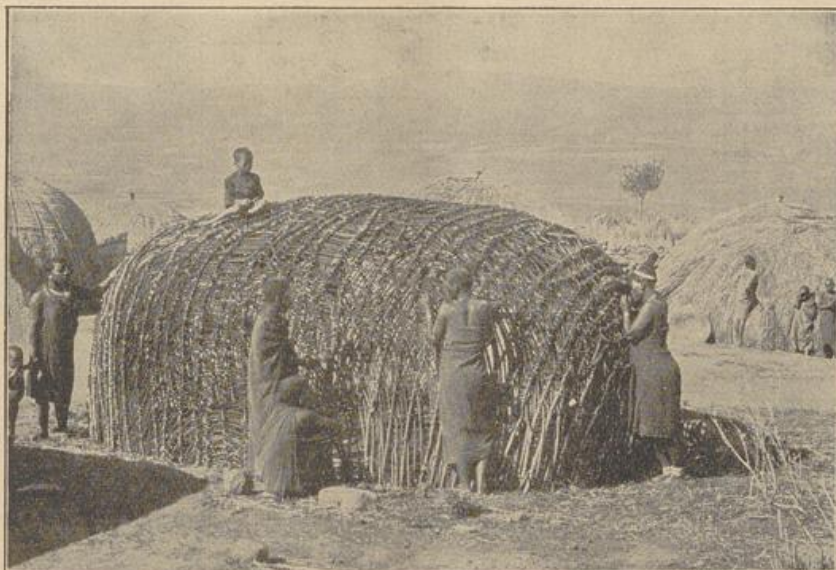
Am Gerüst für eine Zulu-Hütte wird das Flechtwerk zur Unterlage für das Deckgras eingeflochten.
