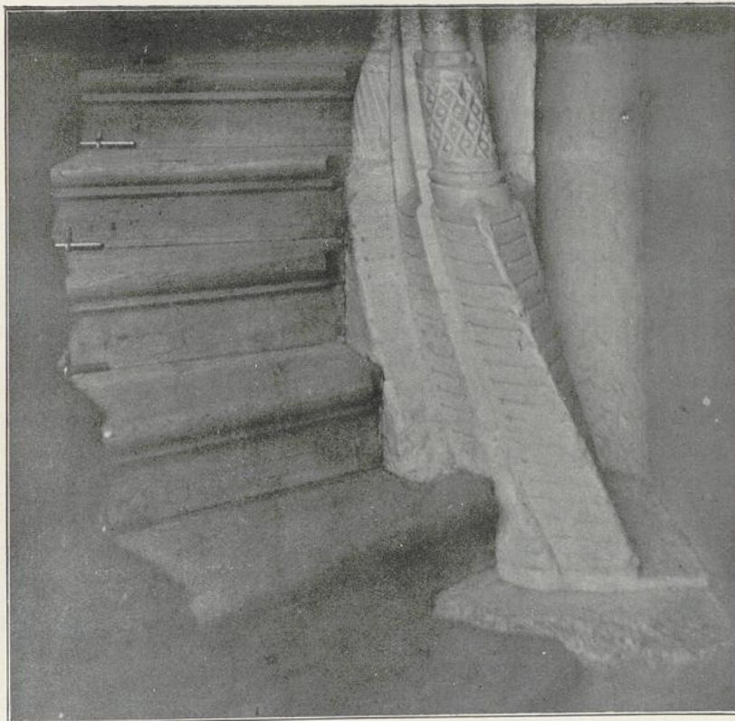
Fig. 58. Spindelanfänger der Nordwesttreppe im Schlosse zu Dresden.
