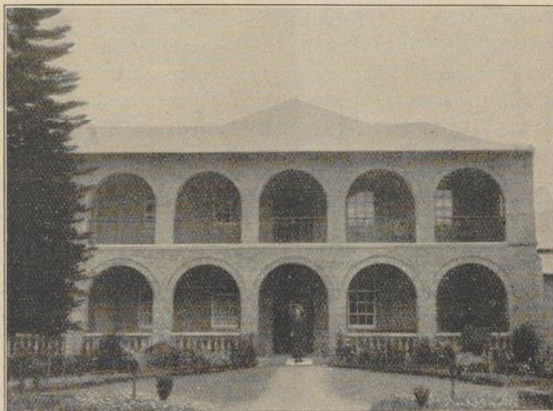
Das neue Krankenhaus für unsere Kongregation in Mariannhill.
