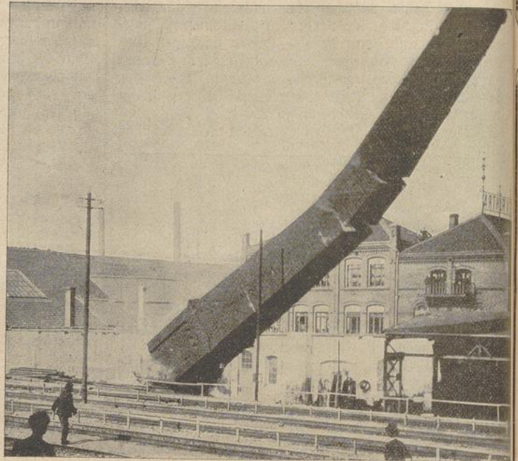
Das Umlegen eines Fabrikschornsteins. Momentphotographie im Augenblick des Umlagens.
