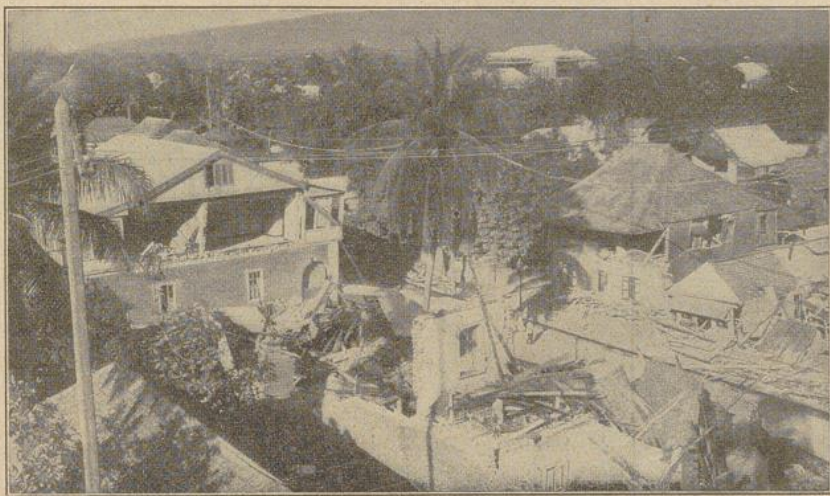
Eine vom Erdbeben zerstörte Straße in Kingston, Jamaika.
