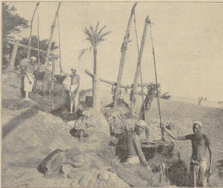
Bewässerung der Felder vermittelt des Schadufs.
