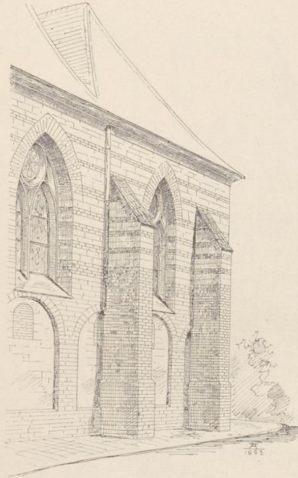
Fig. 56. Esch. Das nördliche Seitenschiff der Pfarrkirche.
