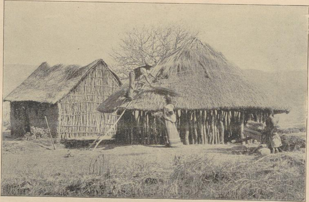
Beim Decken einer Kaffernhütte.
