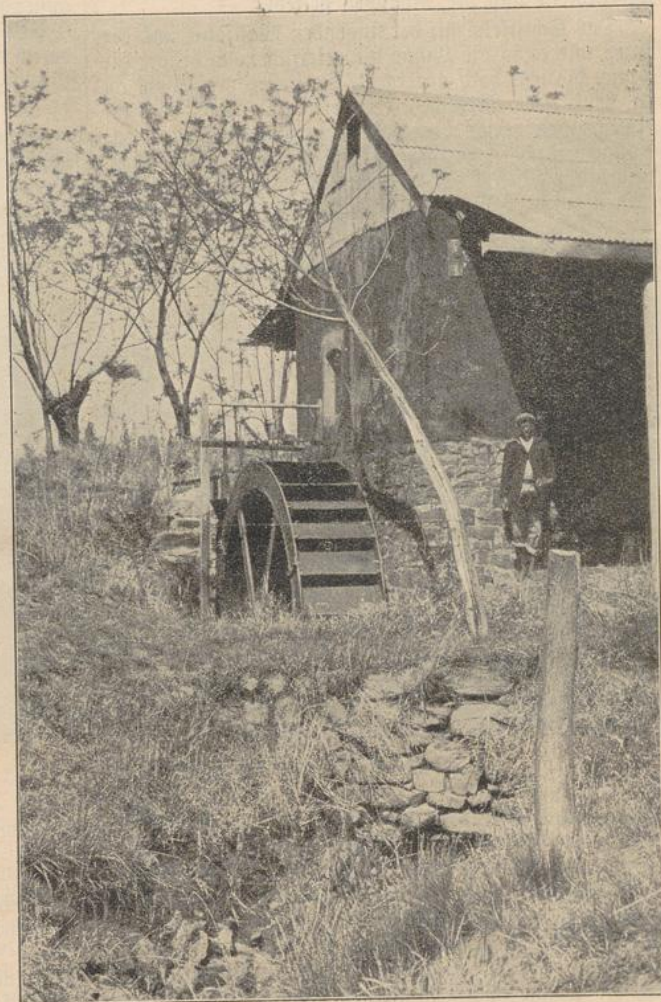
Mühle der Station Einsiedeln.
