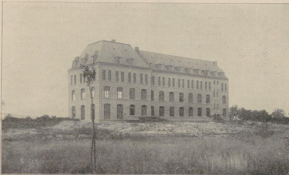
Das Mariannahiller Missionshaus „St. Paul“ von Nordosten aus gesehen. (Neubau, fertiggestellt 1. Mai 1913, bezogen 1. Juni 1913.)
