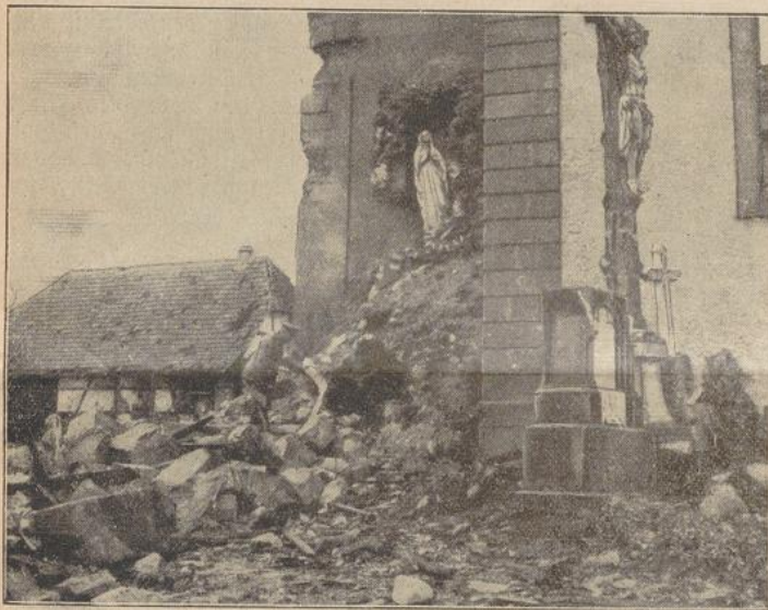
Blick in die zerstörte Kirche von Oberburnhaupt.
