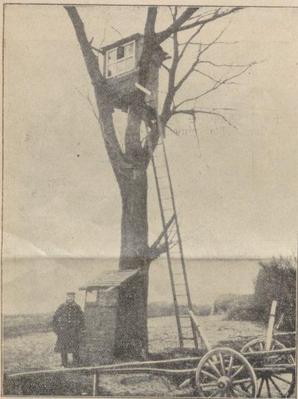
Ein wetterfestes Ausguckhäuschen in einer Baumkrone.
