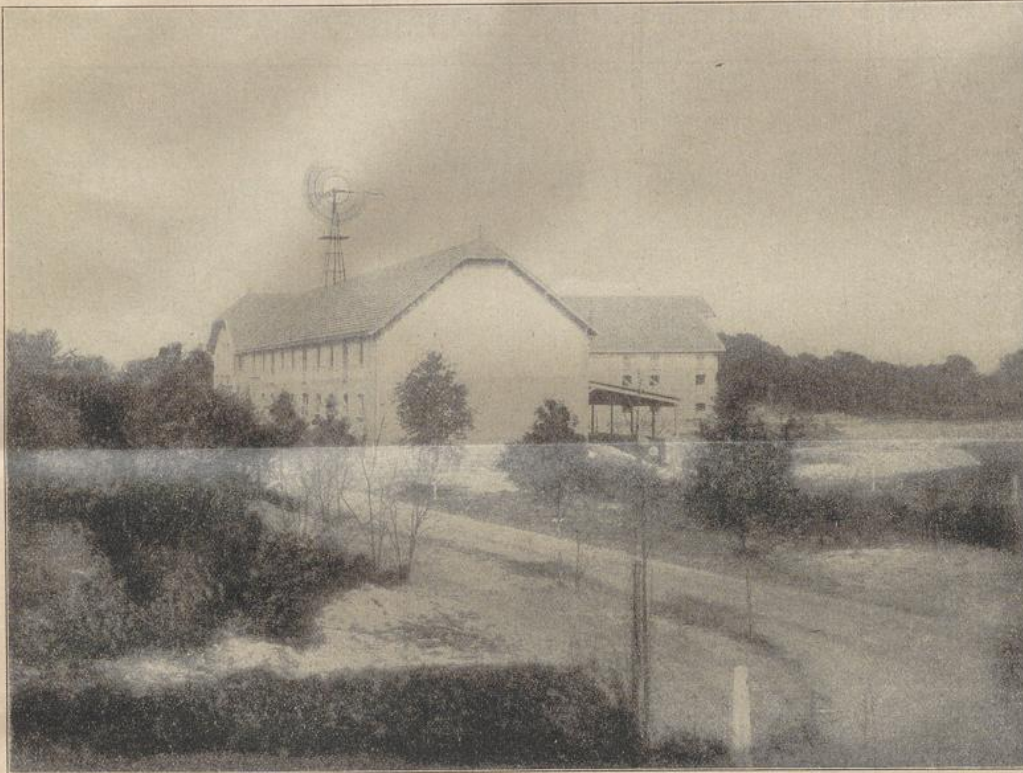
Oekonomie-Gebäude des Mariannhiller Missionshauses St. Paul.
