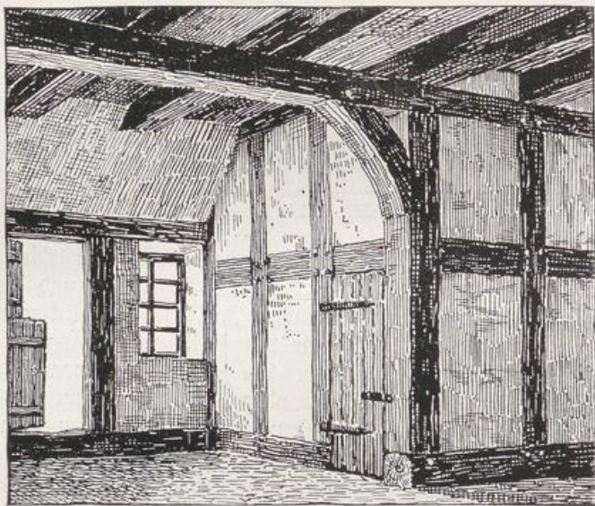
Abb. 29. Senne I, Haus 38. Die Dielenständer tragen indirekt durch den „Luchstrang“ die Balken. Hier fehlt das eigentliche „Luchtholt“ unter dem Luchstrange.
