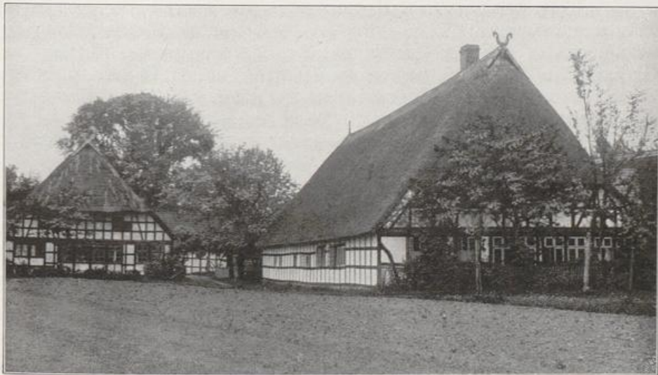
Abb. 14. Zweiflünderhaus oder Klibbungshaus in Alswede bei Lübbecke mit „Kipp“ und Giebelzierden: Gek und Pferdetopf. Kipp = schräger Teil des Giebels.
