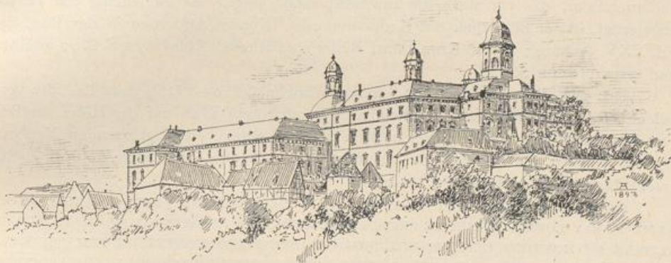
Fig. 33. Bensberg. Gesamtansicht des neuen Schlosses.
