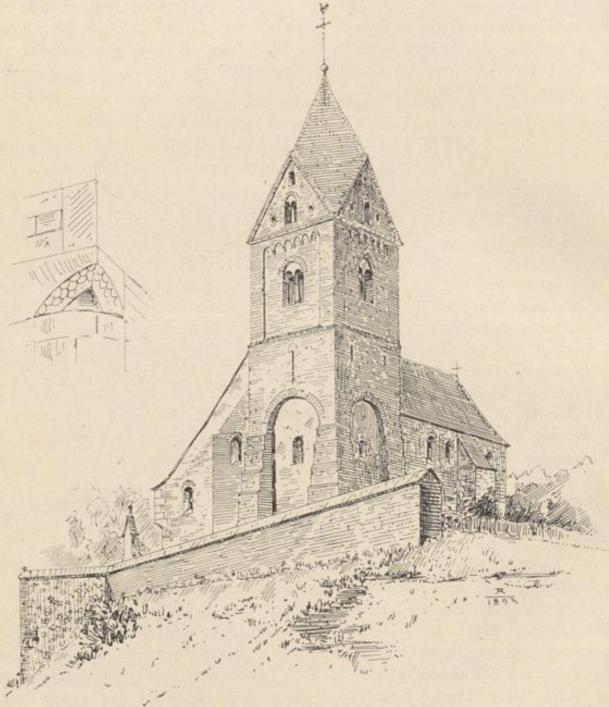
Fig. 60. Nieder-Zündorf. Ansicht der alten katholischen Pfarrkirche.
