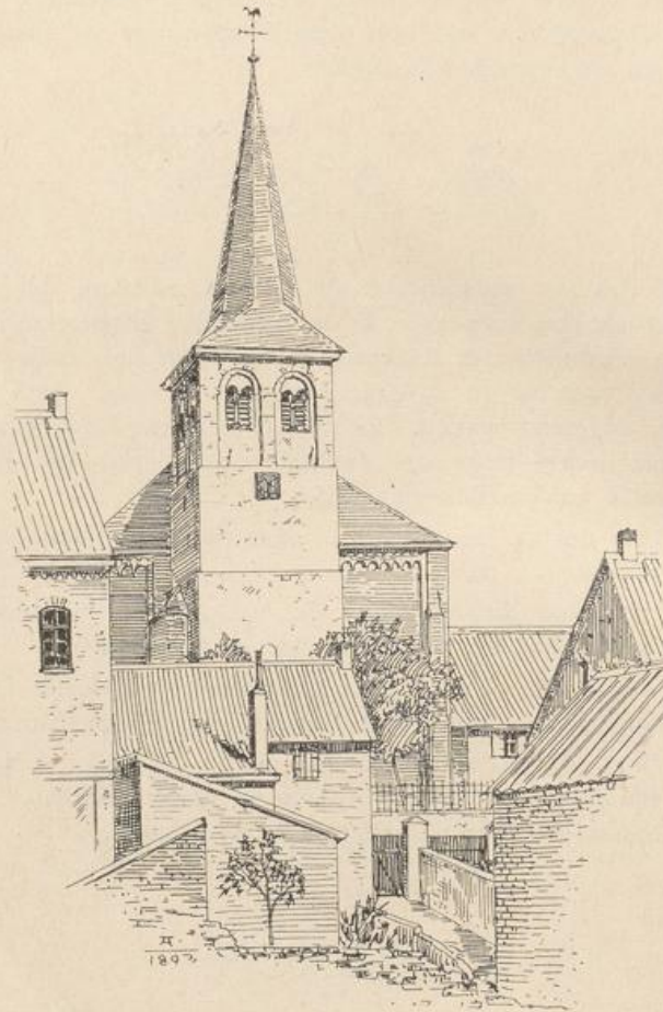
Fig. 84. Urbach. Ansicht der katholischen Pfarrkirche vor dem Neubau des Turmes.
