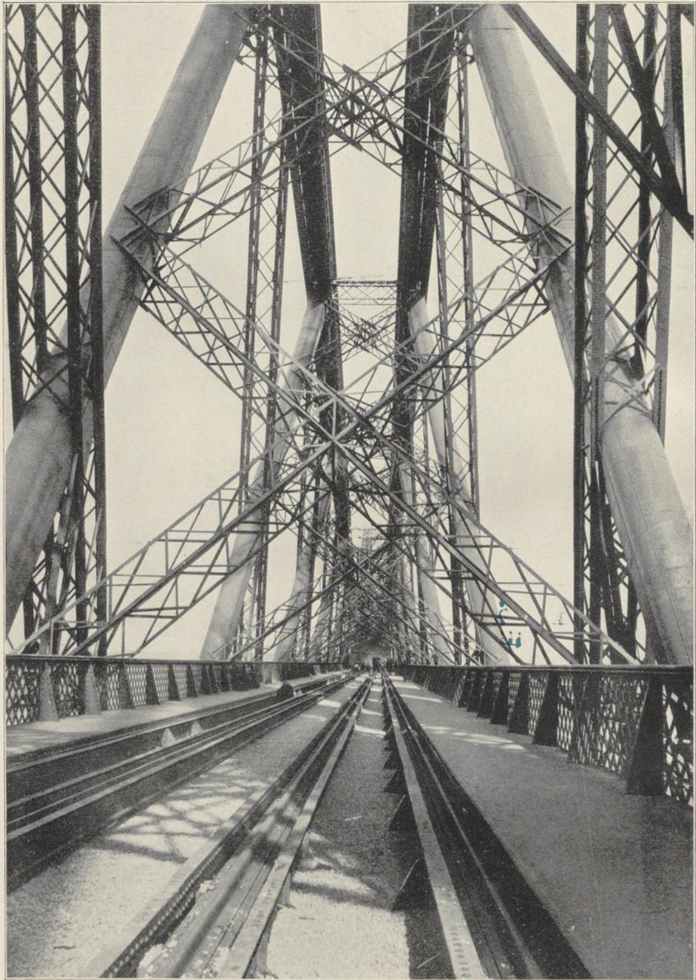
Brücke über den Firth of Forth bei Edinburgh
