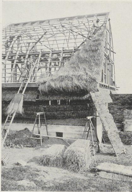
Das Dach wird mit Lehm- schindeln gedeckt
