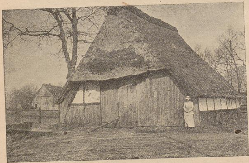
Aufnahme von Lindner. Abb. 9. Schuppen bei Wederkesa (Hann.). Strohdach mit Wulst aus Heidekraut. Das Fachwerk der Längswand rechts unten ist zum besseren Luftdurchzug nur mit durchflochtener Holzstakung ausgelegt, während diese oben mit Lehm verschmiert, glattgeputzt und gekalkt ist.
