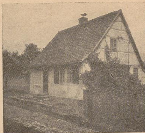
Abb. 4. Ein sauber gepflegter Bau aus luftgetrockneten Lehmsteinen in Oldisleben. Die Dachgiebel bestehen aus Fachwerk, das mit Lehmsteinen ausgemauert ist.
