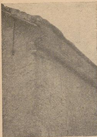
Abb. 3. Einzelheit eines gestampften Lehmhauses. An der Längswand ist der Putz abgefallen; die Höhe der einzelnen Stampfschichten ist erkennbar.
