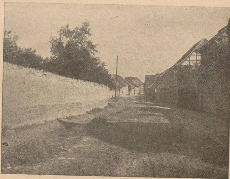
Abb. 7. Gartenmauer aus gestampftem Lehm mit hohem Bruchsteinsockel und einer Abdeckung aus Dachpfannen. Trotzdem der Putz abgefallen ist, hat die Mauer dank der guten Abdeckung dem Wetter standgehalten.
