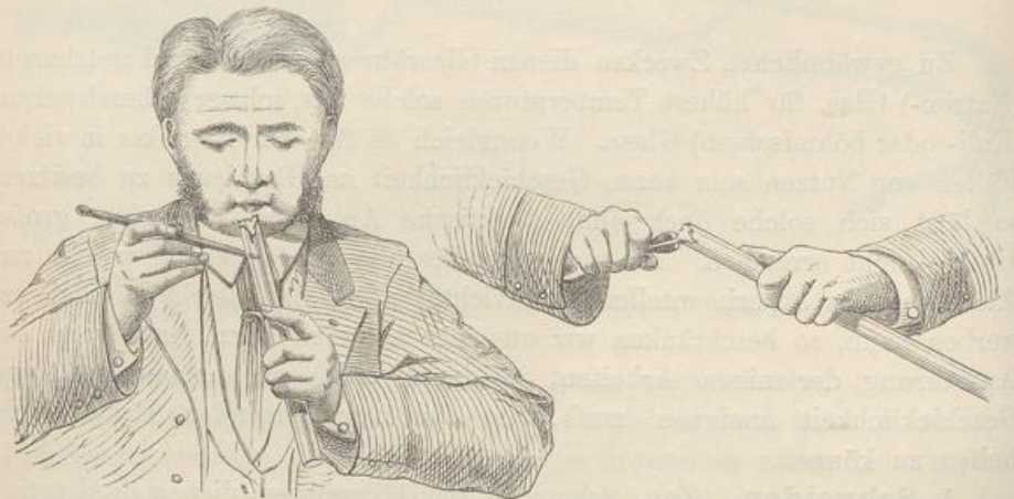
Fig. 117. Absprengen unreiner Glasränder. Fig. 118. Abkneipen unreiner Glasränder.
