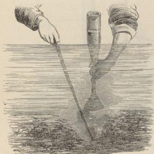
Fig. 861. Auffangen von Sumpfgas.
