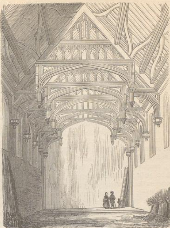
Fig. 354. Stichbalkendach mit Kehlbalcken und Hängewerk, aus dem Palast zu Eltham (um 1400).
