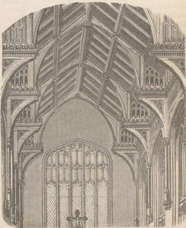
Fig. 355. Stichbalkendach ohne Kehlbalcken aus St. Stephan in Norwich, um 1450.
