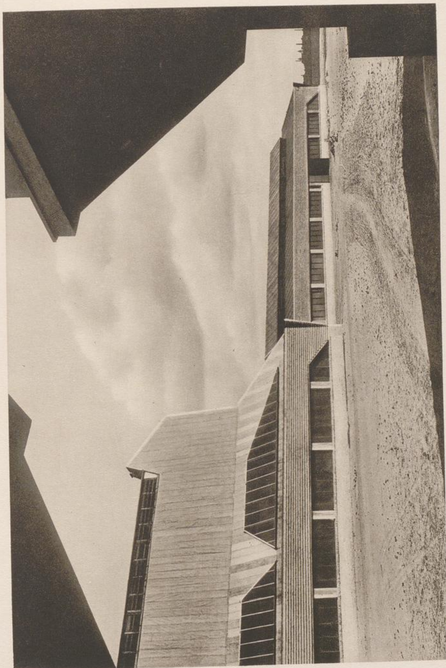
Erich Mendelsohn: Hutfabrik Friedrich Steinberg, Hermann & Co., Luckenwalde bei Berlin. 1923. Blick auf die Färberei
