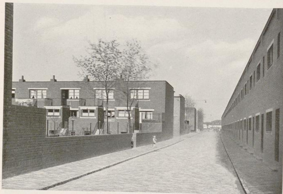
Karl Pregizer und Hermann Bräuhäuser: Siedlung am Dickelsbach, Duisburg. 1927
