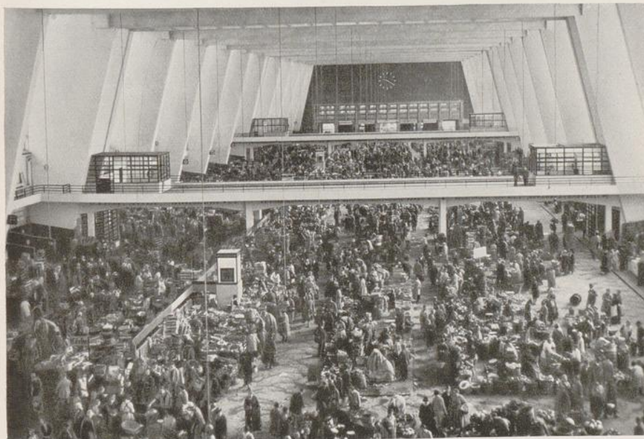
Martin Elsaesser: Großmarkthalle, Frankfurt a. M. 1928
