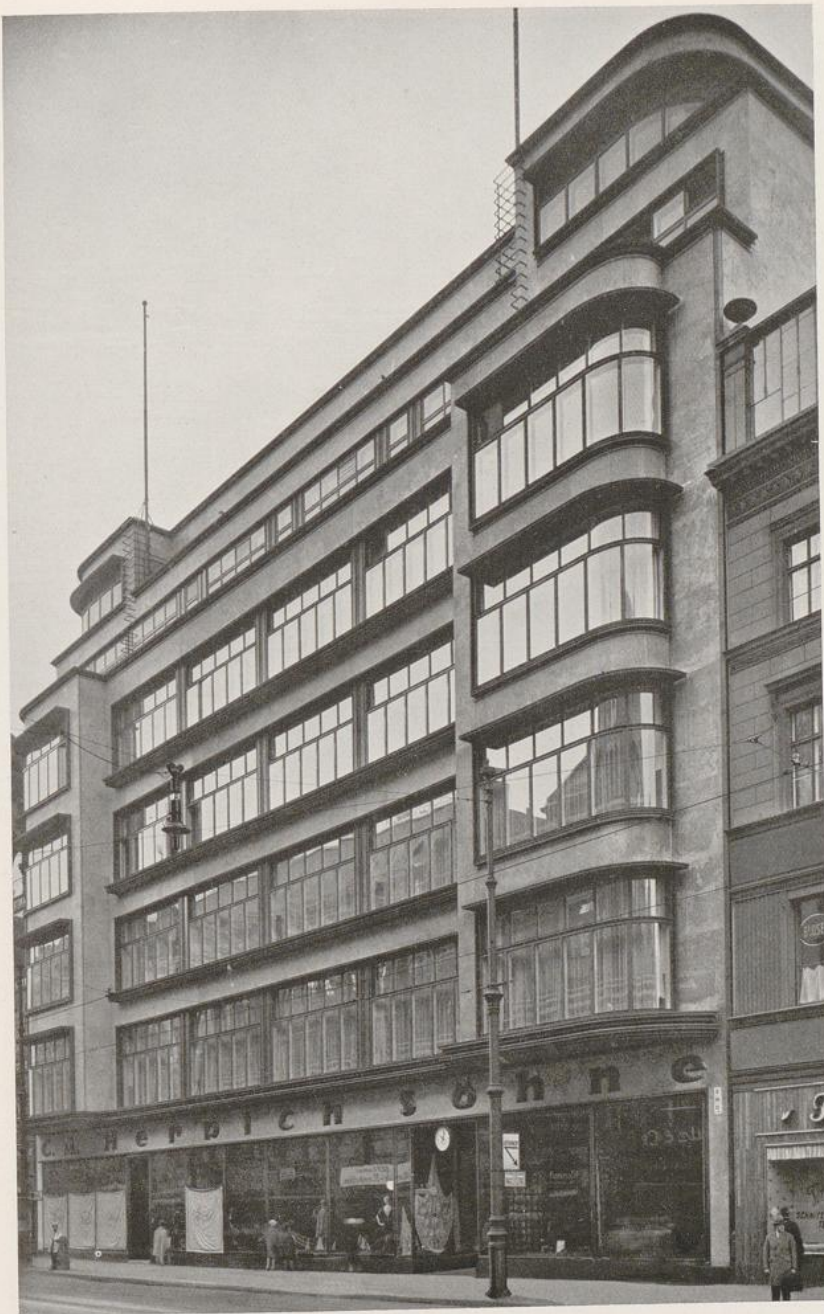
Erich Mendelsohn: Geschäftshaus Herpich, Berlin. Umbau 1925-1928
