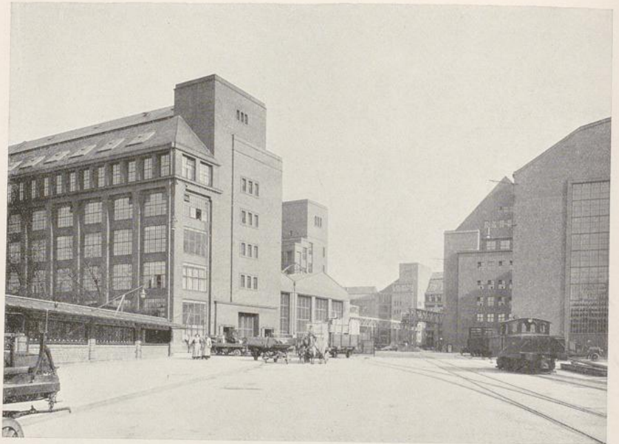
Peter Behrens: Blick in den Fabrikhof der AEG., Berlin, Am Humboldthain
