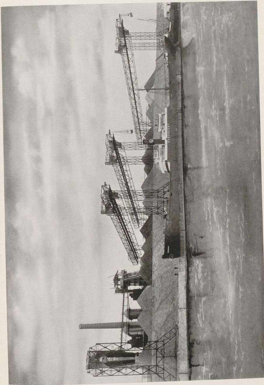
Fa. Demag: Erzentrade-Anlage für ein Hochofenwerk, Lübeck
