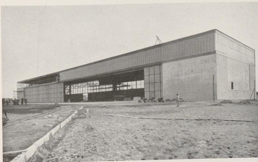
Paul Thiersch: Flugzeughalle, Schkeuditz bei Halle. 1928
