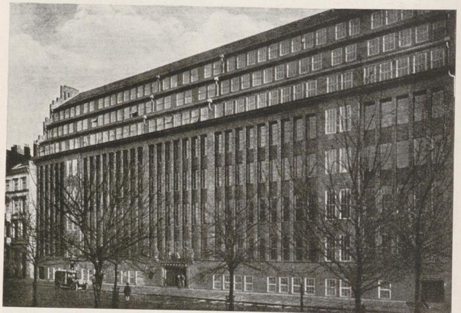
Ferdinand Sckopp und Wilhelm Vortmann: Haus des Deutschnationalen Handlungsgehilfen-Verbandes, Hamburg. 1921
