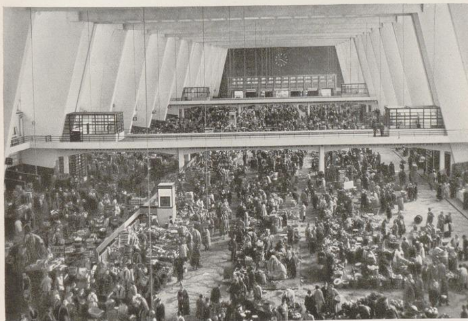
Martin Elsaesser: Großmarkthalle, Frankfurt a. M. 1928
