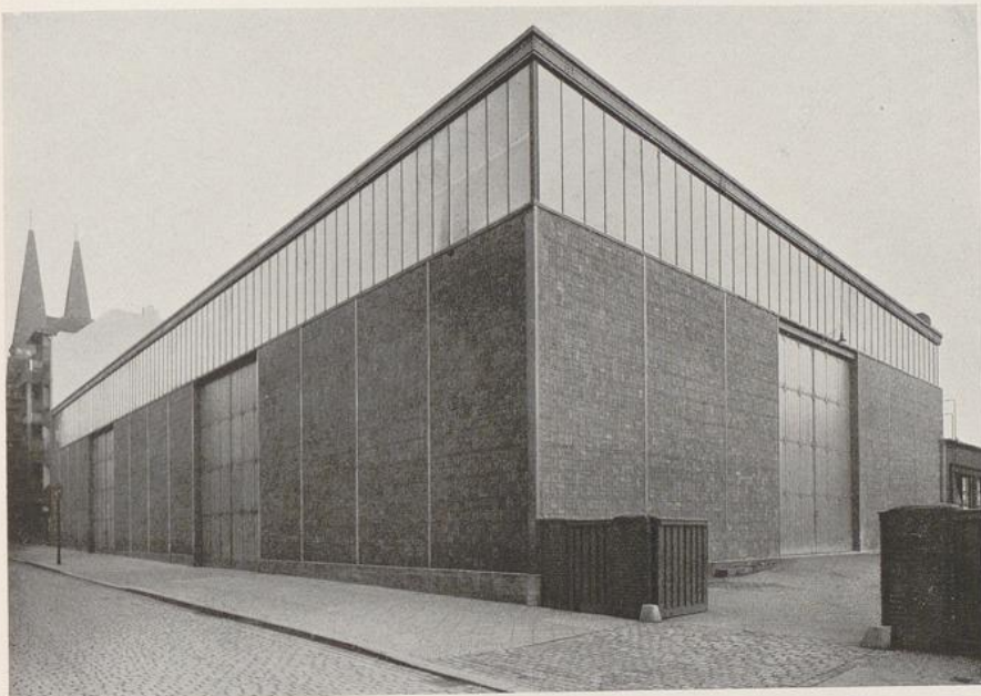
Werner March: Flugzeug-Montagehalle, Berlin, Sprengelstraße. 1928
