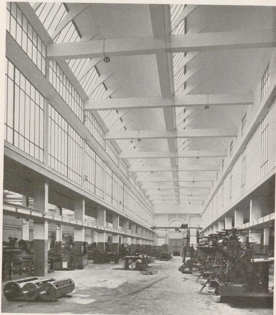
Auguste und Gustave Perret: Fabrikhalle Marinoni, Montataire (Dép. Oise). 1927. (Shed-Dächer in Eisenbeton)
