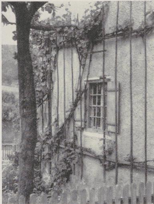
Spalier aus senkrechten, geschälten Rundstangen an einem Bauernhaus in Pielenhofen an der Naab
