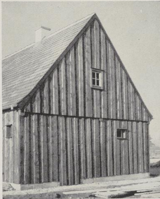
Die aus senkrecht überlappenden Brettern in der Art der Tafel 5b ausgeführte Schalung ergibt mit ihrem kräftigen Profil eine schönere, lebendigere Wirkung als die vielfach übliche Art aus stumpf gestoßenen Brettern mit dünnen Deckleisten. Das Windbrett ist als Zahnleiste ausgebildet.
