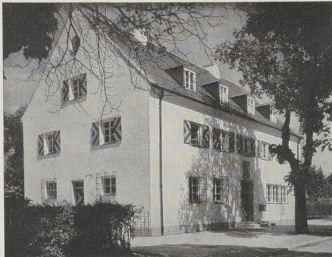
Stehende Blechgaube am Post- amt Moosburg. Baugestaltung: Reichspostdirektion München
