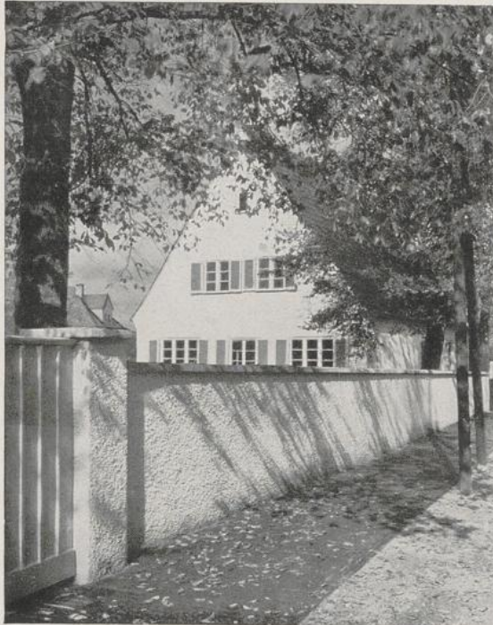
Geschlossene verputzte Gartenmauer mit Betonabdeckplatte in Obermenzing (vgl. S. 8)
