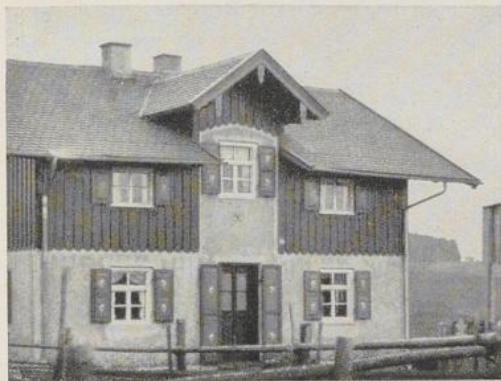
Gegenbeispiele: Ganz ungeeignet zum Ausbau ist das stark überstehende Pfettendach des bayerischen Hochlandes und der bayerischen Ostmark. Auch kleinere Ausbauten überschneiden infolge der flachen Dachneigung fast immer den First und bringen damit eine Unruhe in das Orts- und Landschaftsbild, die schon viel von der Schönheit unserer Heimat verdorben hat. Auf die technischen Nachteile des Ausbaues flachgeneigter, vorspringender Dächer wurde schon auf Seite 32 hingewiesen.
