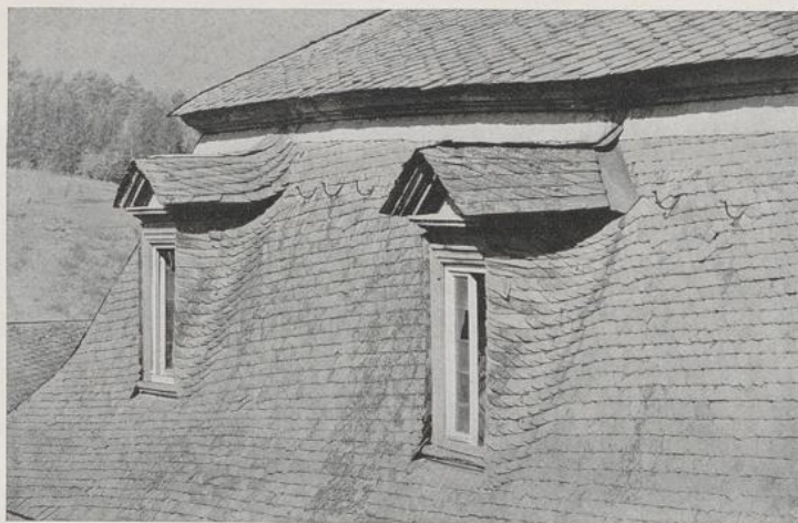
Alte Schiefergaube mit eingehender Kehlendeckung (lfs.) u. neue Gaube mit fliegend gedeckter Kehle (r.) aus Braunfels (Lahn) In Schieferdächer fügen sich Dachgauben besonders gut ein, weil zur Eindeckung, zur Kehlenausdeckung und zur Verkleidung der senkrechten Flächen derselbe Werkstoff verwendet werden kann. Leider ist die hier gezeigte richtige Handwerkskunst fast ganz verloren gegangen.
