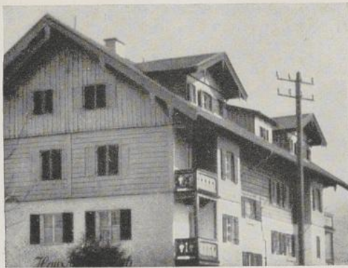
Gegenbeispiele: Ganz ungeeignet zum Ausbau ist das stark überstehende Pfettendach des bayerischen Hochlandes und der bayerischen Ostmark. Auch kleinere Ausbauten überschneiden infolge der flachen Dachneigung fast immer den First und bringen damit eine Unruhe in das Orts- und Landschaftsbild, die schon viel von der Schönheit unserer Heimat verdorben hat. Auf die technischen Nachteile des Ausbaues flachgeneigter, vorspringender Dächer wurde schon auf Seite 32 hingewiesen.
