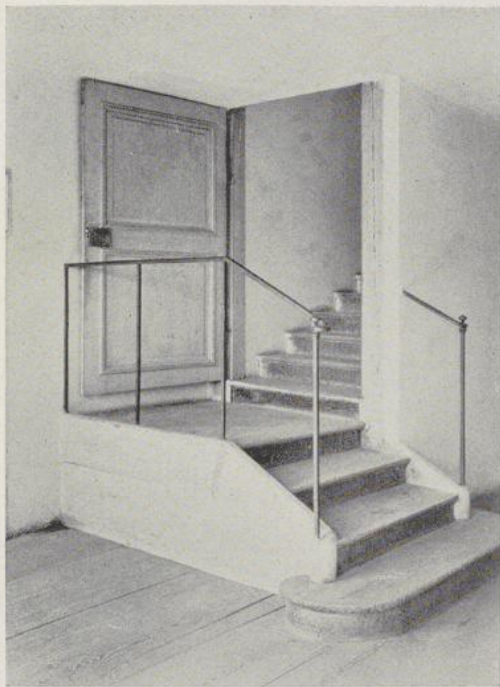
Treppe zum Speicher im Schloßchen Lustheim Besonders beachtenswert ist hier die massive Holzwanne, welche in ihrer ganzen Länge auf den Fußboden aufgesetzt ist. In sie sind die Stäbe des einfachen Eisengeländers, die infolge der untergeordneten Bedeutung der Treppe ohne Zierformen sind, von oben eingesteckt.
