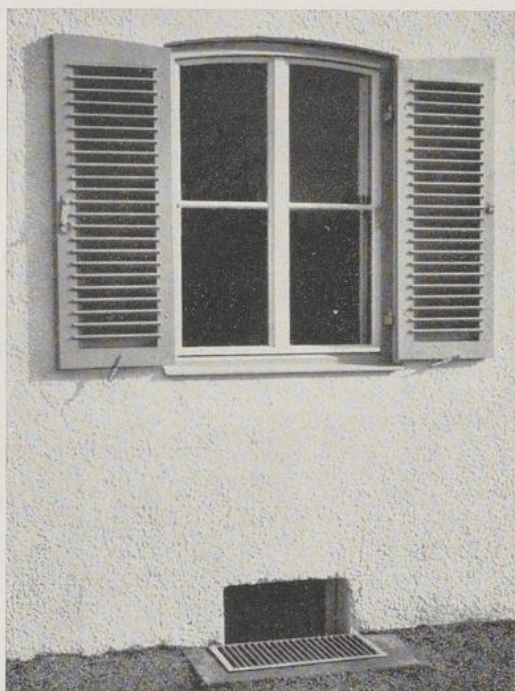
Fenster mit Segmentbogensturz und geradem Sturz aus Scheiben von aufrechtem Seitenverhältnis Abmessung beim linken Beispiel: Breite 1,18 m, Höhe 1,44 m (seitlich) beziehungsweise 1,50 m (in der Mitte), beim rechten Beispiel: Breite 1,10 m, Höhe 1,56 m. Die Anordnung eines flachen Segmentbogensturzes ist oft ein einfaches Mittel, um eine reizvolle Belebung der Außenansichten zu erzielen.
