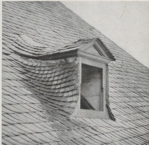
Alte Schiefergaube mit eingehender Kehlendeckung (lfs.) u. neue Gaube mit fliegend gedeckter Kehle (r.) aus Braunfels (Lahn) In Schieferdächer fügen sich Dachgauben besonders gut ein, weil zur Eindeckung, zur Kehlenausdeckung und zur Verkleidung der senkrechten Flächen derselbe Werkstoff verwendet werden kann. Leider ist die hier gezeigte richtige Handwerkskunst fast ganz verloren gegangen.
