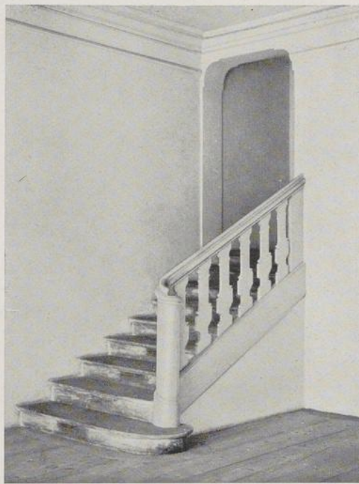
Diellentreppe aus dem Schloßchen Lustheim Im Gegensatz zu nebenstehend gezeigter Speichertreppe ist hier die Diellentreppe mit Rücksicht auf den Raum absichtlich reicher durchgebildet. Profil von Handlauf und Wange setzen sich im Krümmung fort. Die Stufen liegen ohne Verwundung einer Wandwange im Mauerwerk auf.
