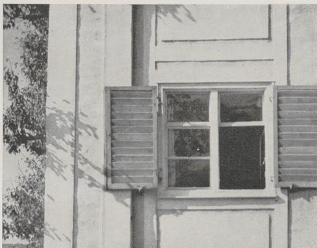
Vorbildliche Erneuerung eines alten Verputzes an der ehemaligen Drangerie in Rempten im Allgäu
