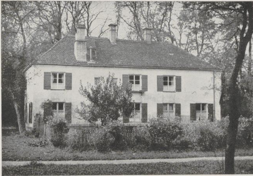
Wächterhaus zur Badenburg im Nymphenburger Schlosspark in München (18. Jahrh.) Das knappe, wenig vorspringende, gemauerte und verputzte Gesims ist seit Jahrhunderten die für Altbayern und Oberschwaben typische, bodenständige Gesimsform bei steilen Dächern, die erfreulicherweise auch bei Neubauten wieder in zunehmendem Maß angewandt wird. Die technische Einzeldurchbildung zeigt Tafel 4.
