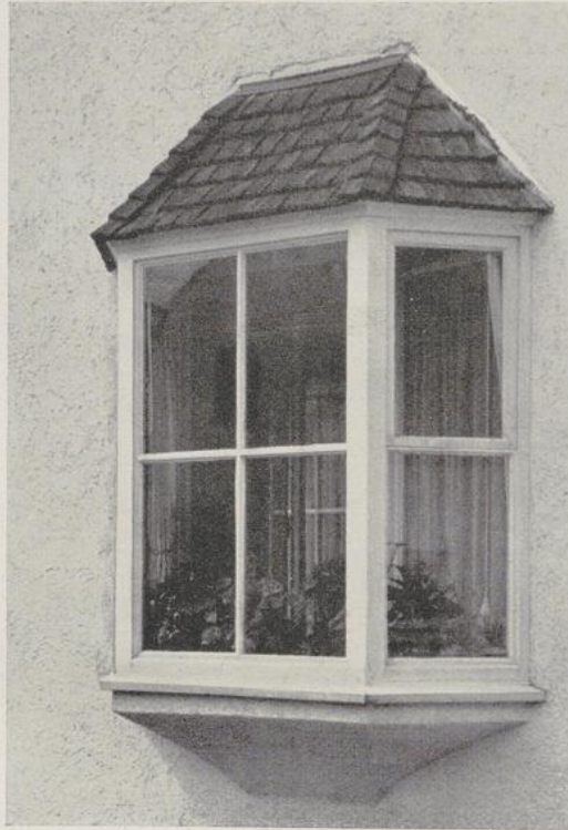
Blumenerker an einem mittelgroßen Baukörper mit Schindeldeckung und Steinkonsole. Architekt Bruno Diebler, München.
