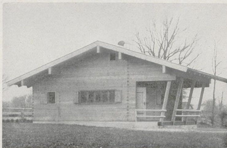
Max Schoen †, München. Ferienhaus in Lenggries (Oberbayern). Rund 170 cbm (ohne Schuppen). Erbaut 1932. Blockbau (12 cm stark), innen gehobelte Vertäfelung auf rauher Schalung. Deckung mit Kunstschiefer. Raum für 6 Betten. Waschraum könnte im Schuppen eingebaut werden. Herd im Wohnraum. Reizvolle und zweckmäßige, aus dem Alpenhaus abgeleitete Form ohne Salontirolorei
