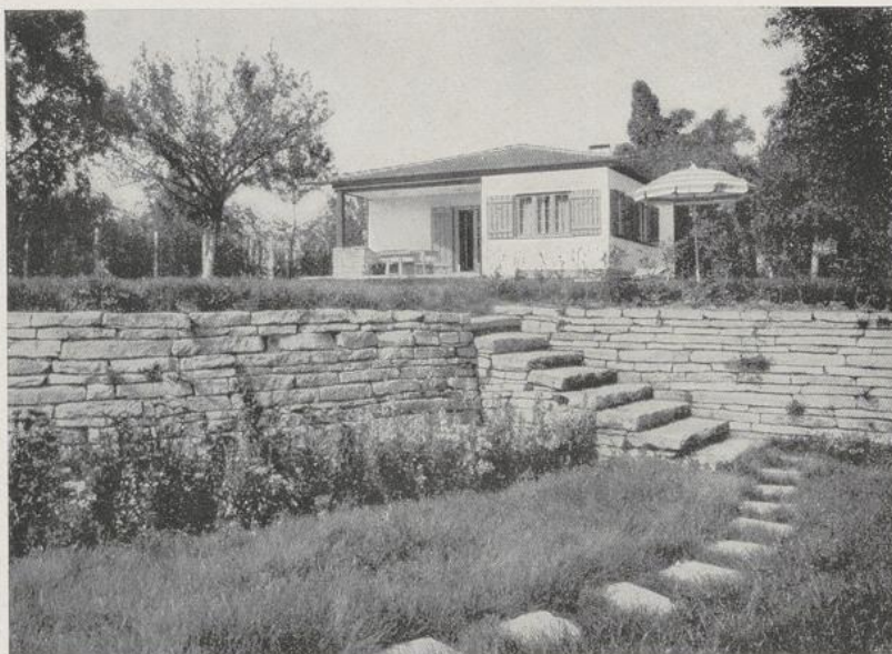
Otto Roth, München. Wochenendhaus bei Göppingen. Rund 300 cbm (ausschl. Garage). Erbaut 1936. Fachwerk mit beiderseitiger Plattenverkleidung und Putz
