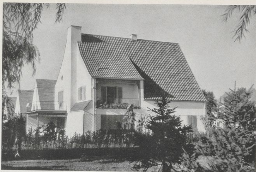
Emil Freymuth, München. Einfamilienhaus in Ramersdorf, anschließend an die Muster-siedlung. Umbauter Raum 1233 cbm. Erbaut 1936. Im Erdgeschoß ein großer Wohnraum, etwa 45 qm. Von hier aus kann die Treppe direkt erreicht werden, als kurze Verbindung vom Obergeschoß zum Freisitz. Bad. Mädchenzimmer im Giebelausbau. Kellergeschoß: Waschküche mit Bügelzimmer, Heizung mit Koksraum, Wirtschaftskeller
