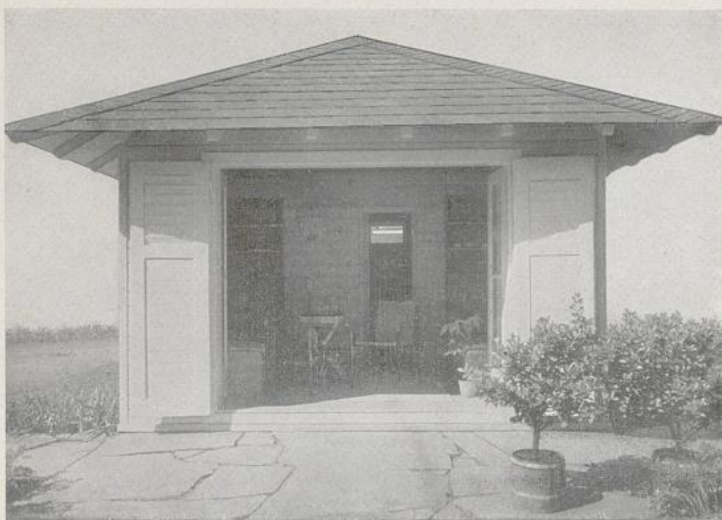
Erich Boltens, Wien. Wochenendhaus. Rund 50 cbm. Baujahr 1934. Holzriegelwände, beiderseits auf Nut und Feder verschalt, außen gestrichen. Deckung dunkelgrauer Kunstschiefer. Raum für 2 Schlafsofas. Große Doppel-Klapptüren öffnen fast die ganze Breite des Wohn-Schlafraumes. W. C. und Geräteraum von außen zugänglich
