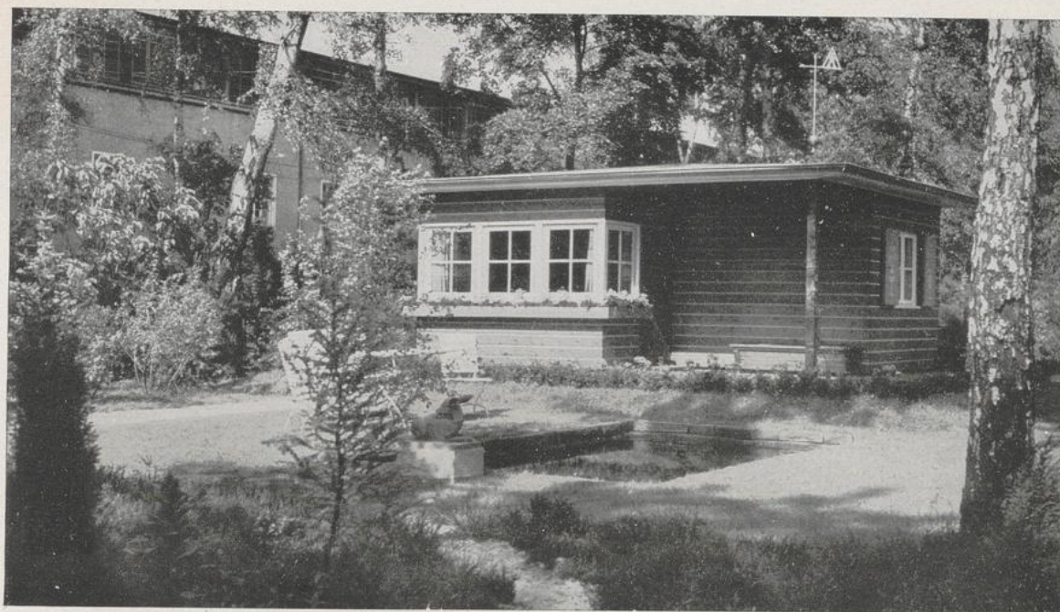
Adolf Springer, Hannover. Wochenendhaus in der Heide. Rund 90 cbm. Holzfachwerk, verschalt. Deckung Blech oder Ruberoid. Raum für 2 Betten und Schlafsofa
