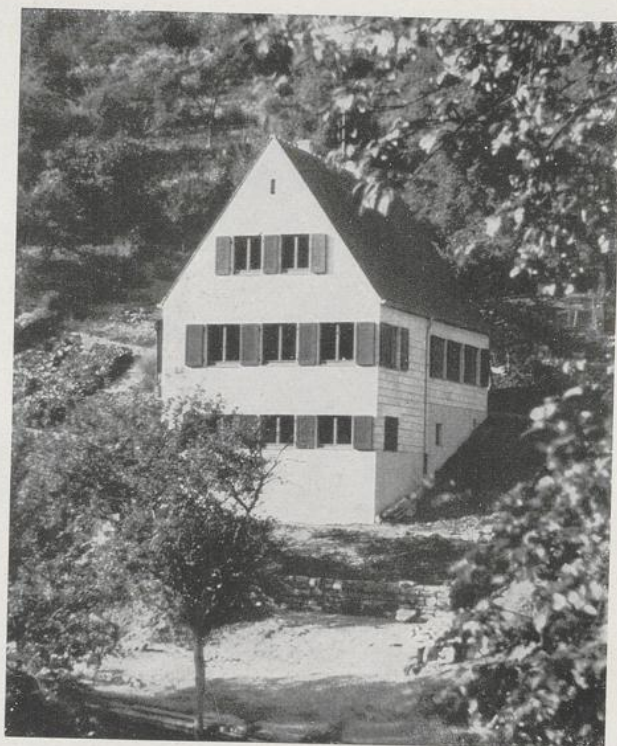
Karl Weidle, Tübingen. Wohnhaus am Hang bei Tübingen. Rund 575 cbm. Erb. 1934. Außenmauern Tuffbeton-Hohlsteine, Zwischenwände Fachwerk. Mostkeller mit Naturstein gewölbt
