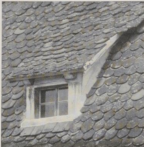
Alte Schleppgauben aus Kasil bei Amberg (links) und aus Mögeldorf bei Nürnberg (rechts)
