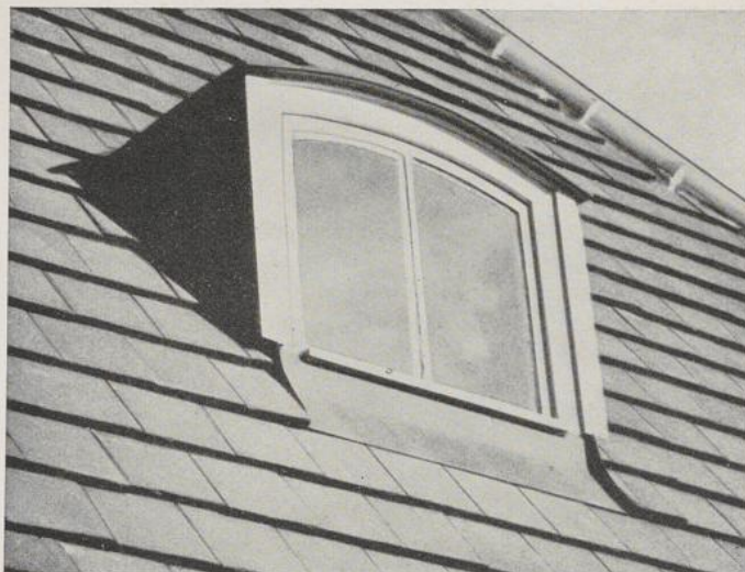
Blechgaube mit segmentbogenförmiger Abdeckung. Gestaltung: Architekt E. A. Bembé in München
