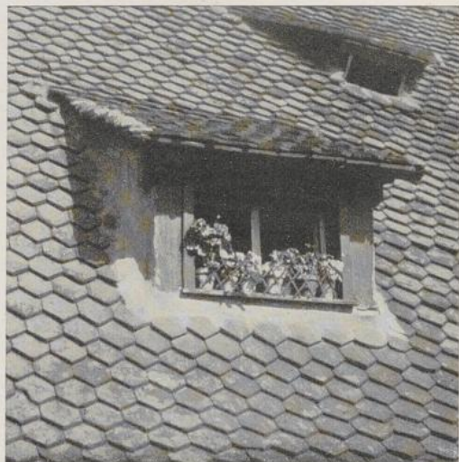
Alte Schleppgauben aus Kasil bei Amberg (links) und aus Mögeldorf bei Nürnberg (rechts)
