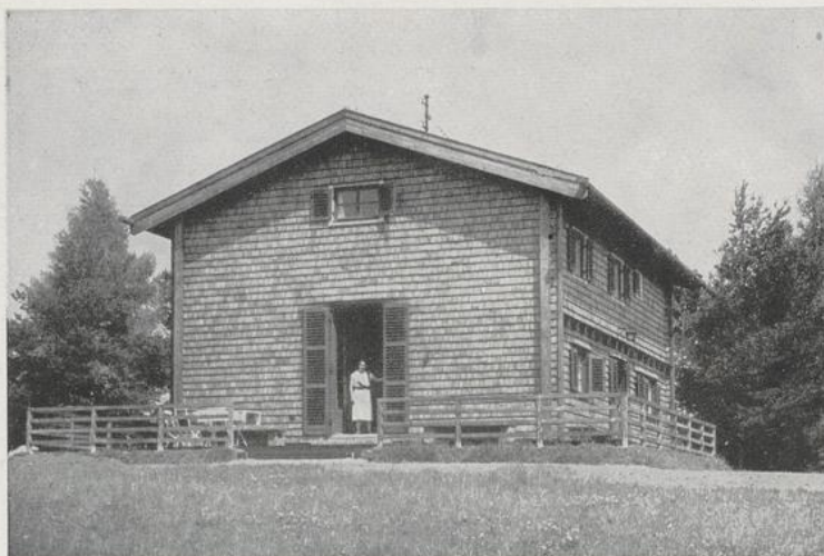
Theo Lechner und Fritz Norkauer, München. Verschindeltes Blockhaus am Starnberger See. Rund 540 cbm. Erbaut 1927. Aus dem Blockverband abgeleiteter Grundriß. Gelungener Versuch, die Bauernhausform sozusagen zu neutralisieren. Dachdeckung Holzschindel
