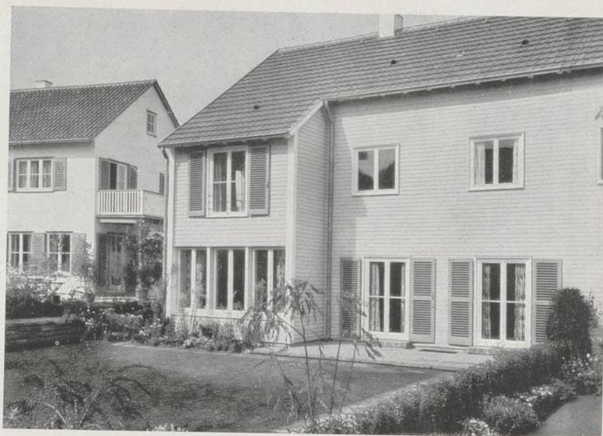
Alfred Kicherer, Stuttgart. Doppelwohnhaus in Stuttgart-Kochenhof. Rund 740 cbm. Erbaut 1933. Fachwerk mit beiderseitiger Schalung und außen Schindelung
