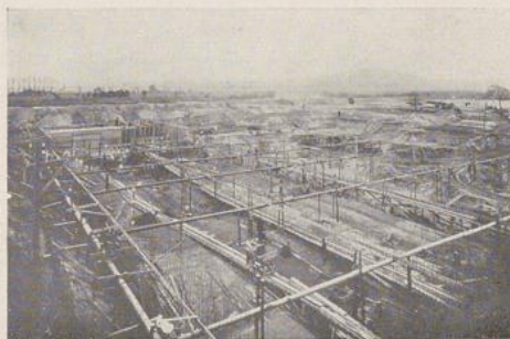
Die Grundwasserabsenkung beim Bau der Kläranlage in Forst i. Laus., ausgeführt für die Stadt Forst. Phot. Bodeker.
