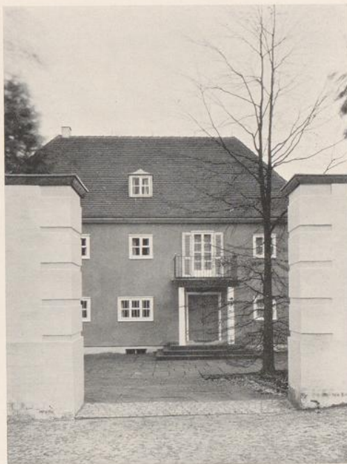
Oben und unten links: Bürgerliche Wohnhäuser von Paul Schmitthenner, Stuttgart. Verputzte Fachwerksbauten aus Einheitsrahmen erstellt. Grundriß S. 145. Unten rechts: Landhaus in einem Park. Verputzter Fachwerkbau. Arch.: Paul Schmitthenner, Stuttgart
