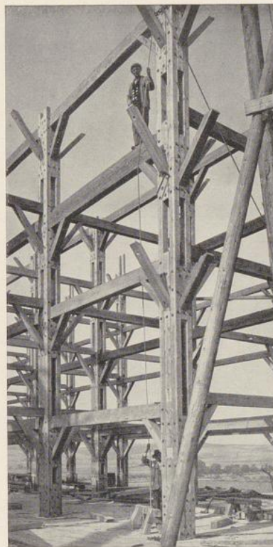
Stützen und Unterzüge des nebenstehenden Industriebaus, Bauweise Cabröl
