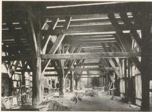
Erdgeschoß des Rathauses in Eßlingen (gebaut 1430). Der Bau ist in eine klare Ordnung von Bundpfosten (Stöcken) eingeteilt. Ein Bund geht immer durch die ganze Baukörpertiefe durch. Die zwischen die einzelnen Pfosten eingespannte Wand ist nur Raumabschluß und überträgt keine Kräfte. Vergleiche S. 127 oben links
