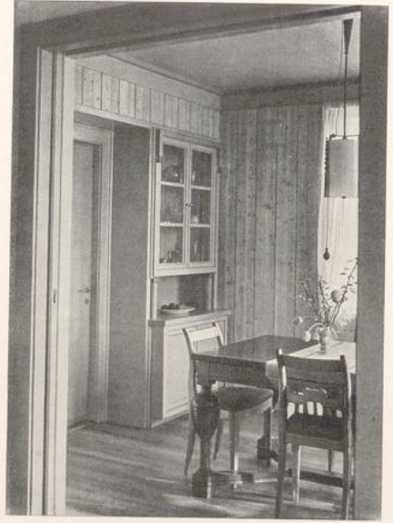
Eigenhaus des Architekten Ludwig von Krogh, Drontheim (Norwegen) in Bohlenbauweise. Konstruktion S. 75, Grundriß S. 143 Das Haus wird durch das Gesimsbrett, das die Stöße der senkrechten Schalung deckt, entscheidend gegliedert. Rechts Innenansicht
