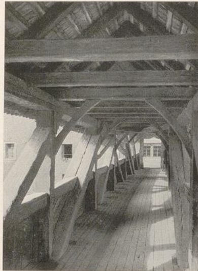
Innenansicht des Fußgängerstegs in Schwäb. Hall. — Rechts: Ingenieurmäßig durchgebildeter Fußgängersteg. Die dachlose Ausbildung bedingt sorgfältige Schutzbehandlung des Holzes gegen Fäulnis. Ausführ.: Karl Kübler, Stuttgart
