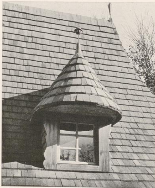
Verschindelter Dachausbau am Postamt Mindelheim, Oberpostdirektion München
