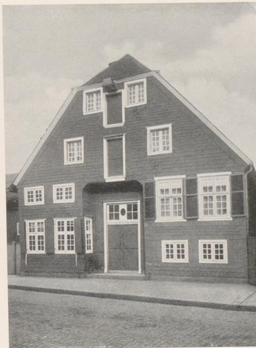
Links: Mit Backstein ausgeriegelt und mit geschnitztem Holz verkleidetes Fachwerk aus Westfalen. Beginn der malerischen Verschleierung im Fachwerkbau. – Rechts: Verschiefter Fachwerksgiebel aus Westfalen. (Nach Kerckerinck, „Alt-Westfalen“)
