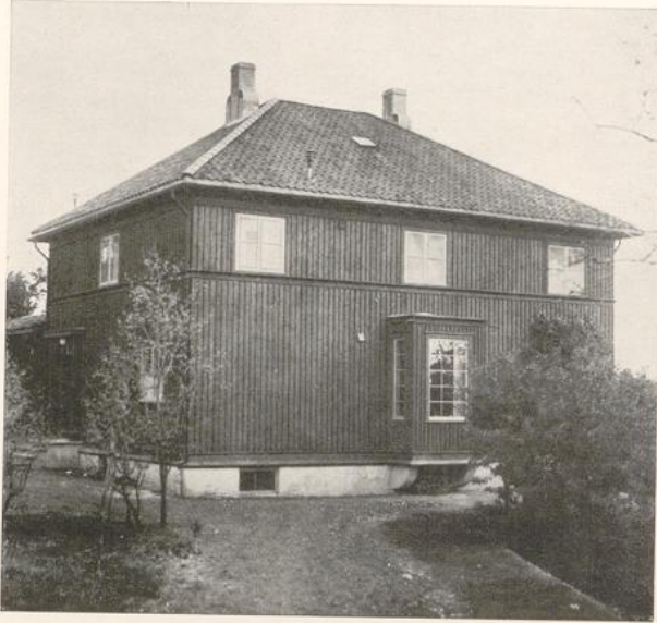
Eigenhaus des Architekten Ludwig von Krogh, Drontheim (Norwegen) in Bohlenbauweise. Konstruktion S. 75, Grundriß S. 143 Das Haus wird durch das Gesimsbrett, das die Stöße der senkrechten Schalung deckt, entscheidend gegliedert. Rechts Innenansicht
