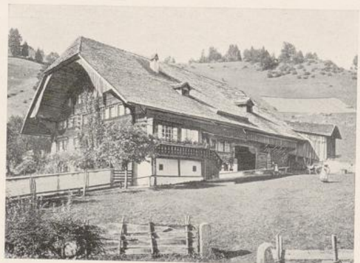
Haus aus dem Emmental in Blockbau. Charakteristisch das vorspringende Dach mit Flugsparren
