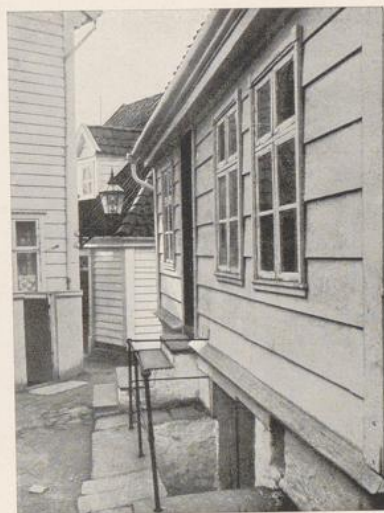
Fischerhäuser aus Bergen (Westnorwegen). Konstruktion S. 71. Der Anschluß der Fensterverkleidung an die Stülpschalung ist auf dem unteren Bild besonders gut zu erkennen. (Nach „Schumann, Bergens Billeder“)
