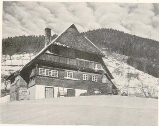
Zwei Schwarzwaldhäuser. Konstruktion: Alemannischer Bundbau (Erklärung S. 123), Wände mit Bohlen ausgesetzt. Beachte die Eckfenster, die hier im Gegensatz zum Blockbau ohne konstruktive Schwierigkeiten angeordnet werden können
