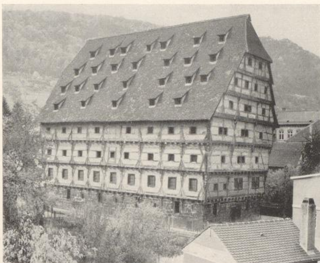
„Kanonenhaus“ in Geislingen (gebaut um 1500), alemannische Bundbauweise. (Phot. Württ. Bildstelle) – Rechts: Stützen und Unterzüge im „Neuen Bau“ zu Schwäb. Hall (gebaut um 1525). Stützen, Bäume und Schapelhölzer Eiche, das übrige Fichte
