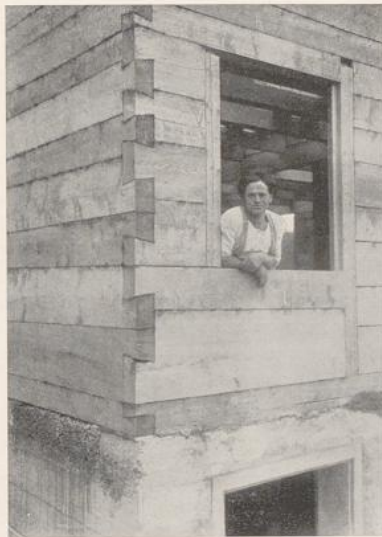
Blockbau aus Einsiedeln (Schweiz). Die Schwebezapfen der senkrechten Fensterstöcke sind deutlich sichtbar. Die Wand wird später verschindelt. Phot. Prof. Jenny-Dürst, Zürich
