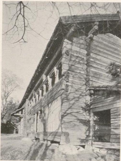
Eckansicht eines der oben gezeigten Häuser aus Dalarne, bei dem die verstrickte Eckverbindung der beschlagenen Rundhölzer gut zu sehen ist
