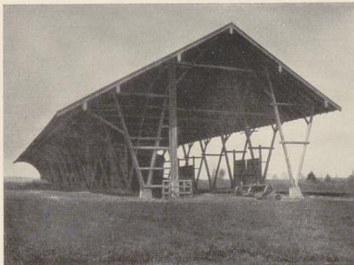
Feldscheune mit einseitigem Vordach, gute Zufahrtsmöglich- keit (hoher Betonsockel zur Sicherung der Stützen gegen Feuch- tigkeit, Längsaussteifung erscheint etwas schwach) gebaut von der Bauabteilung des bayer. Innenministeriums
