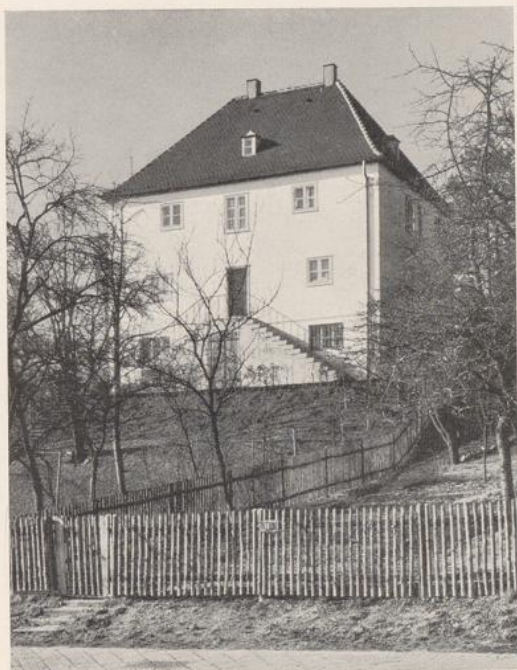
Oben und unten links: Bürgerliche Wohnhäuser von Paul Schmitthenner, Stuttgart. Verputzte Fachwerksbauten aus Einheitsrahmen erstellt. Grundriß S. 145. Unten rechts: Landhaus in einem Park. Verputzter Fachwerkbau. Arch.: Paul Schmitthenner, Stuttgart
