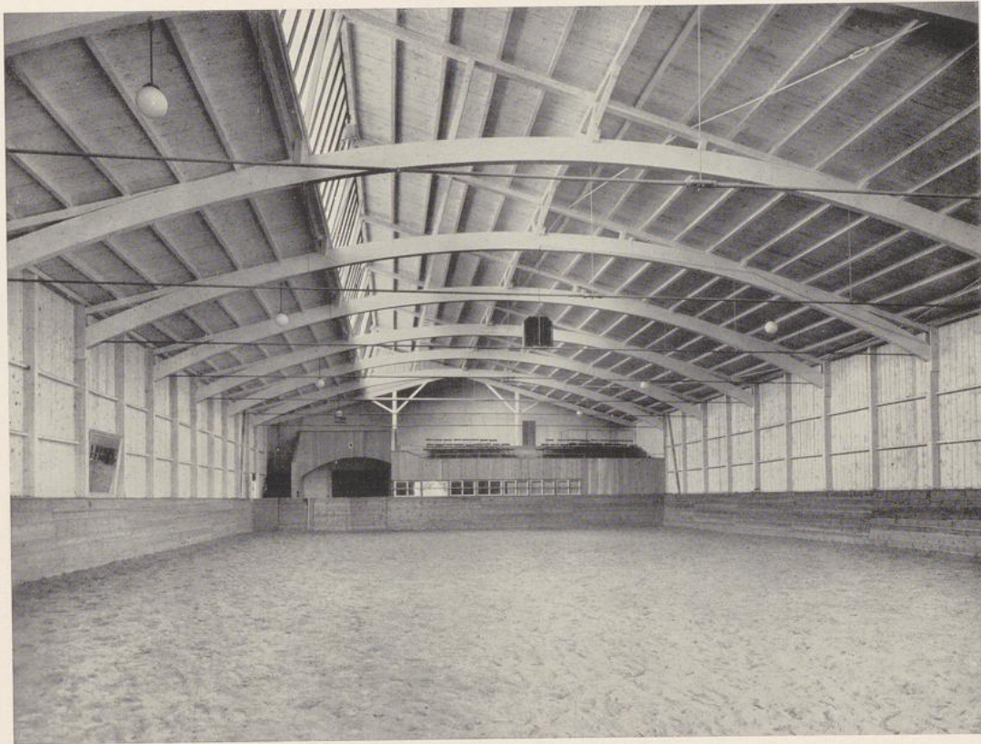
Reithalle Gallenklinge, Stuttgart, Arch.: Heinz Wetzel, Stuttgart. Geleimte Bogenbinder mit Eisenzugstange. Aufnahme der quergerichteten Windkräfte durch parabelförmige Rundeisenverbände. Einseitige Lichtzuführung von Norden zur Vermeidung von Lichtflecken in der Bahn. Grundriß S. 145. Ausführung Karl Kübler AG., Stuttgart
