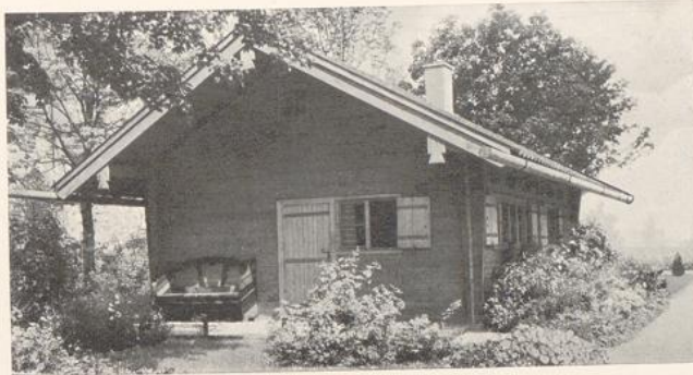
Sommerhaus, Arch.: Lechner & Norkauer, München. Grundriß S. 142. Das Traufwasser wird durch die weit überstehende hölzerne Dachrinne abgeleitet, Abfallrohr würde beim Setzen des Blockbaus ausknicken. Eckverbindung S. 23. Hersteller: Matthias Bauer, Ebenhausen (Isartal)
