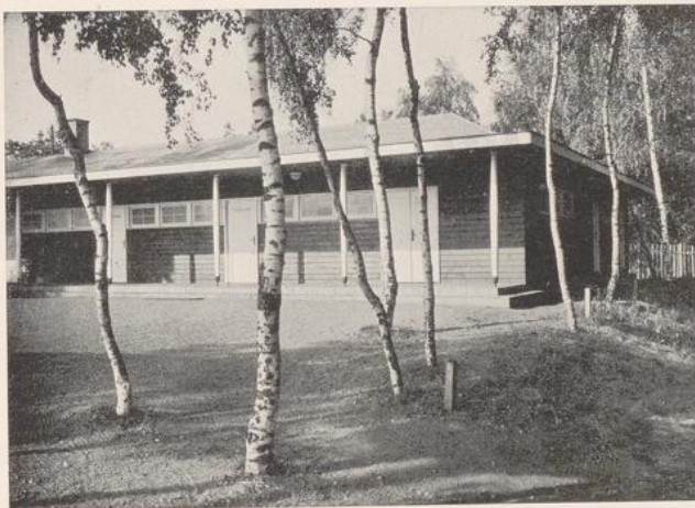
Links: Außenansicht der Umkleieräume des Postsportplatzes in Nürnberg. Zieht man zur Ausbildung überdachter Vorplätze die Deckenbalken vor, so ergeben sich immer plumpere Gesimse als bei der Ausführung mit herabgezogenem Dach. Rechts ein Schalterhäuschen, Entwurf Oberpostdirektion München
