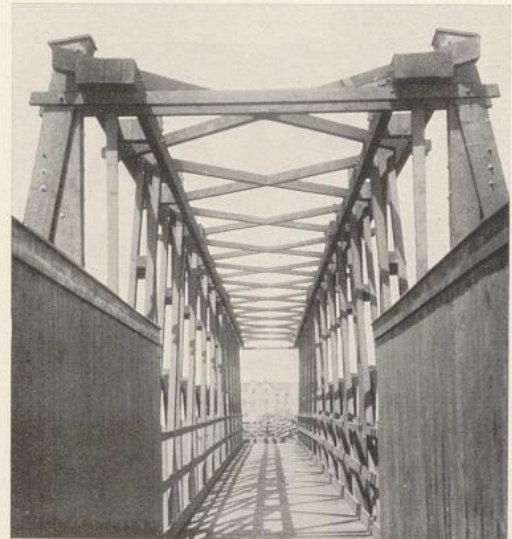
Innenansicht des Fußgängerstegs in Schwäb. Hall. — Rechts: Ingenieurmäßig durchgebildeter Fußgängersteg. Die dachlose Ausbildung bedingt sorgfältige Schutzbehandlung des Holzes gegen Fäulnis. Ausführ.: Karl Kübler, Stuttgart
