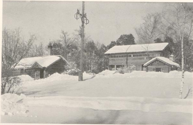
Bauernhäuser aus Dalarne (Schweden), Blockbau aus Rundhölzern. Das hier gezeigte Beispiel mit seiner Galerie sucht an Genialität des Einfalls und der maßstäblichen Durchbildung seinesgleichen. (Phot. Nordisches Museum, Stockholm)
