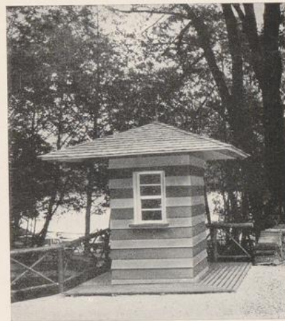
Links: Außenansicht der Umkleieräume des Postsportplatzes in Nürnberg. Zieht man zur Ausbildung überdachter Vorplätze die Deckenbalken vor, so ergeben sich immer plumpere Gesimse als bei der Ausführung mit herabgezogenem Dach. Rechts ein Schalterhäuschen, Entwurf Oberpostdirektion München
