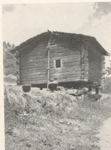
Links: Altes Holzhaus im Isartal. Rechts: Schober (Schlittenhaustyp) aus dem Wallis. Zwischen dem Haus und den kurzen Holzstützen große runde Steinscheiben, um das Haus vor Feuchtigkeit und Ungeziefer zu schützen
