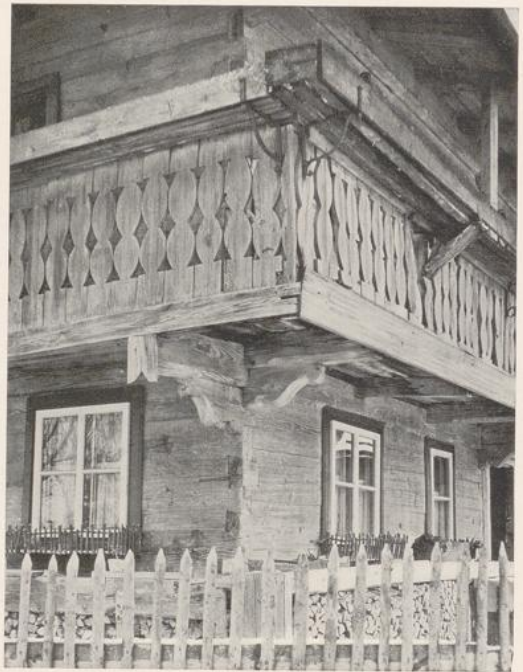
Ecke eines Bauernhauses aus dem Isartal. Um einen festen Eckverband (hier Verzinkung) zu ermöglichen, sind die Fenster weit von den Ecken abgerückt. (Phot. Prof. Lechner)
