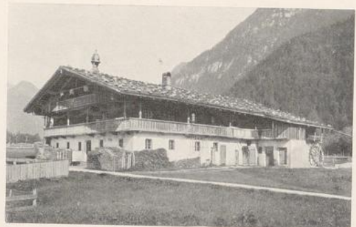
Haus aus Tirol, Schindeldach mit Steinen beschwert
