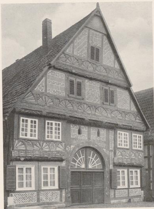
Links: Mit Backstein ausgeriegelt und mit geschnitztem Holz verkleidetes Fachwerk aus Westfalen. Beginn der malerischen Verschleierung im Fachwerkbau. – Rechts: Verschiefter Fachwerksgiebel aus Westfalen. (Nach Kerckerinck, „Alt-Westfalen“)
