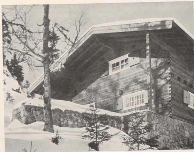
Skihütte, Arch.: Biehler, München. Der hohe senkrechte Pfosten hat einen Schwebezapfen und trägt nicht. Das überstehende Dach wird von den ausgekragten Pfetten getragen. (Das gleiche Konstruktionsprinzip wie beim pompösen Vordach des Hauses aus dem Emmental S. 36. Grundriß S. 142)
