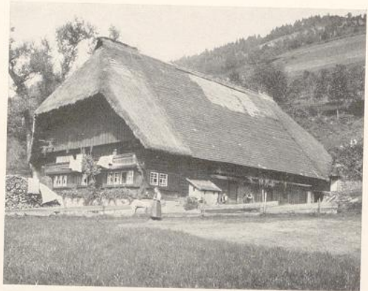
Zwei Schwarzwaldhäuser. Konstruktion: Alemannischer Bundbau (Erklärung S. 123), Wände mit Bohlen ausgesetzt. Beachte die Eckfenster, die hier im Gegensatz zum Blockbau ohne konstruktive Schwierigkeiten angeordnet werden können
