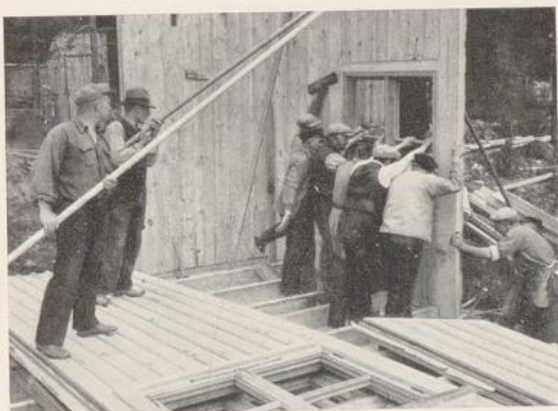
Plattenbauweise der Stadt Stockholm. Konstruktion S. 78, Grundriß S. 143. Die unteren Abbildungen zeigen die Aufstellung eines Plattenhauses. Auf dem letzten Bild sind deutlich die Plattenstöße zu erkennen, die nachträglich mit einem Brett gedichtet werden
