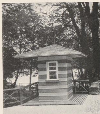
Links: Außenansicht der Umkleieräume des Postsportplatzes in Nürnberg. Zieht man zur Ausbildung überdachter Vorplätze die Deckenbalken vor, so ergeben sich immer plumpere Gesimse als bei der Ausführung mit herabgezogenem Dach. Rechts ein Schalterhäuschen, Entwurf Oberpostdirektion München
