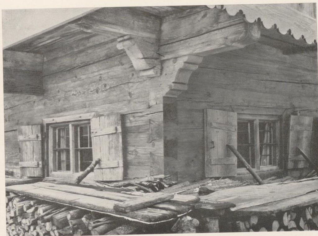
Ecke eines Isartalhauses. Die geschweifte Verzinkung bewirkt eine besonders feste Verbindung der Hölzer. Es ist leider heute nicht mehr möglich, derart gute Eckverbindungen zu machen. Viele heute gebräuchliche Eckverbindungen im Blockbau sind vollkommen wertlos. (Aufnahme Prof. Lechner, München)
