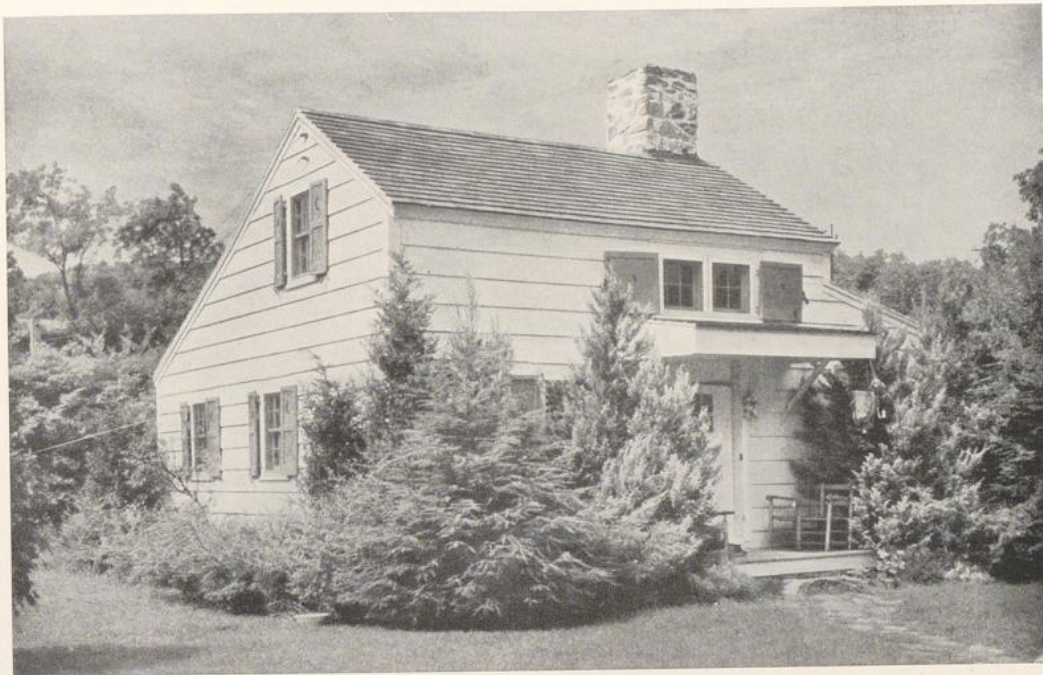
Amerikanisches Einfamilienhaus, Arch.: C. E. Tanner, Conndale. In Amerika gibt es Holzarten, die eine Verschalung mit derart breiten Brettern zulassen
