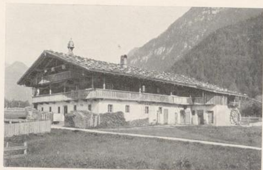
Haus aus Tirol, Schindeldach mit Steinen beschwert
