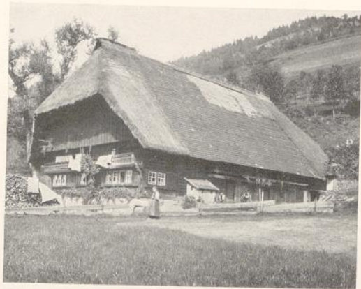
Zwei Schwarzwaldhäuser. Konstruktion: Alemannischer Bundbau (Erklärung S. 123), Wände mit Bohlen ausgesetzt. Beachte die Eckfenster, die hier im Gegensatz zum Blockbau ohne konstruktive Schwierigkeiten angeordnet werden können
