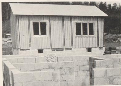
Plattenbauweise der Stadt Stockholm. Konstruktion S. 78, Grundriß S. 143. Die unteren Abbildungen zeigen die Aufstellung eines Plattenhauses. Auf dem letzten Bild sind deutlich die Plattenstöße zu erkennen, die nachträglich mit einem Brett gedichtet werden
