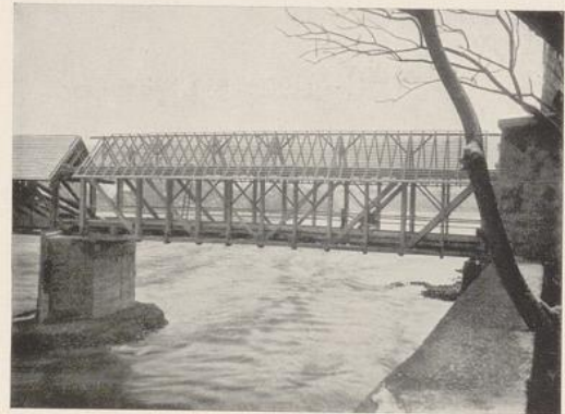
Dieselbe Brücke ersetzt durch neuzeitlichen Fachwerksträger Ausführung: Karl Kübler AG., Stuttgart
