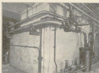
Fig. 154**). Rohrleitungen an den Fundamenten der Dampfmaschinen.
