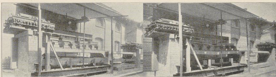
Deckenprüfung mittels Presse.
