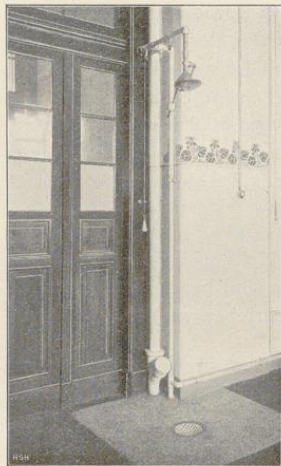
Fig. 118. Türbrause in den Arbeitsräumen.
