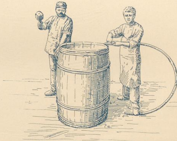
Fig. 45. Das Fassbinden.
